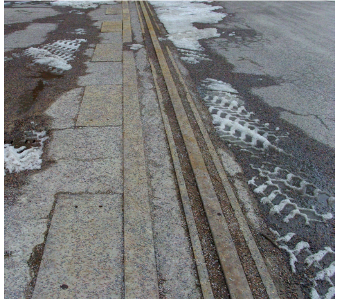
Hietalahdenlaiturin kansitasossa oleva nosturin kisko.
