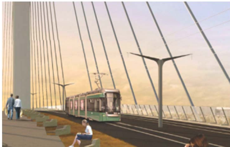
Kuva 19: Havainnekuva - ajolangan kannatinpylväs (HKR / WSP Finland Oy).
