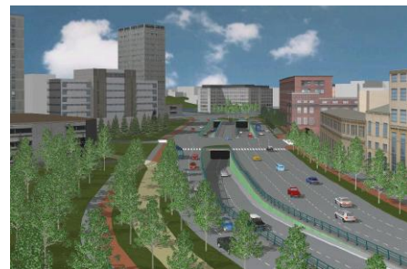
Kuva 68. Keskustatunnelin pohjoinen suuaukko. Kuva: KSV / LOS (2007)
