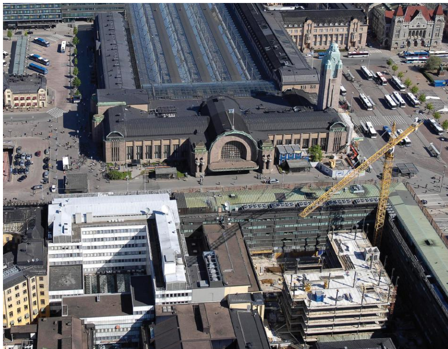
Kuva 3. City-korttelin sisäpihan lisärakennustyömaa vuonna 2010:
