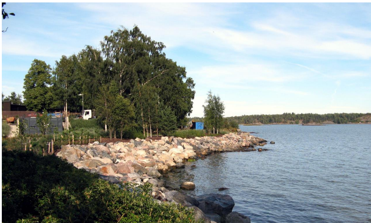
Kuva 13. Palosaaren etelärantaa on vahvistettu isoilla kivillä.
