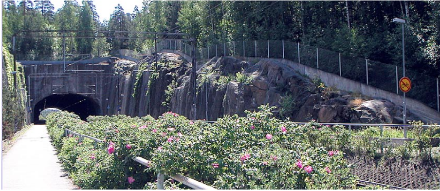
Asema on metromainen ja rakennettu tunneliin.
