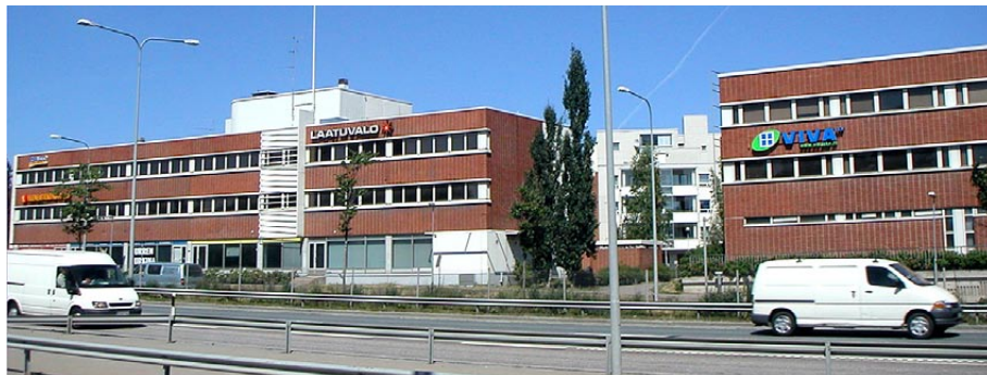
Rakennuksia Kehä 1:n varressa.
