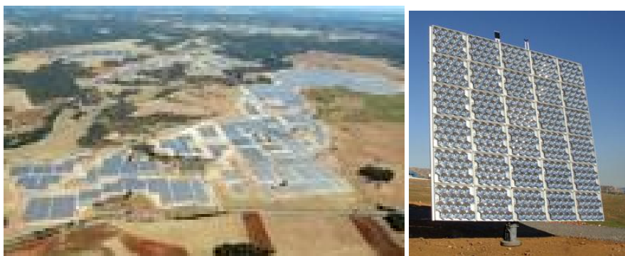
Kuva 3-1. Suoraan verkkoon syöttävä keskitetyn tuotannon 60 MW:n aurinkopaneeli-järjestelmä Espanjan Olmedillassa (Lähde: pvresources.com) ja 6,2 kW:n järjestelmä Espanjassa. [Lähde: Solfocus]
