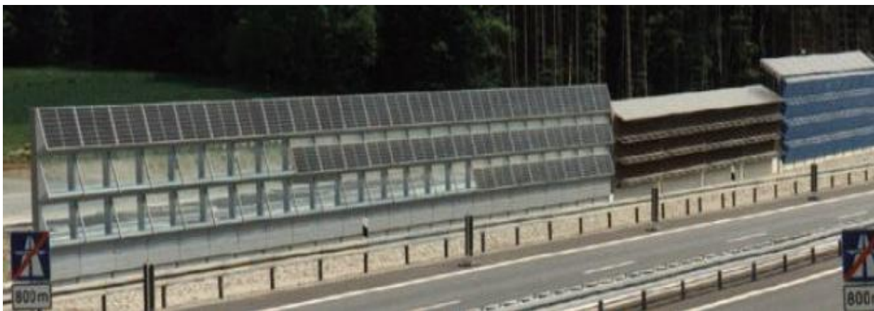
Kuva 3-5. Aurinkopaneelit moottoritien äänivallissa. [Munich, Germany, kuva TNC AG].
