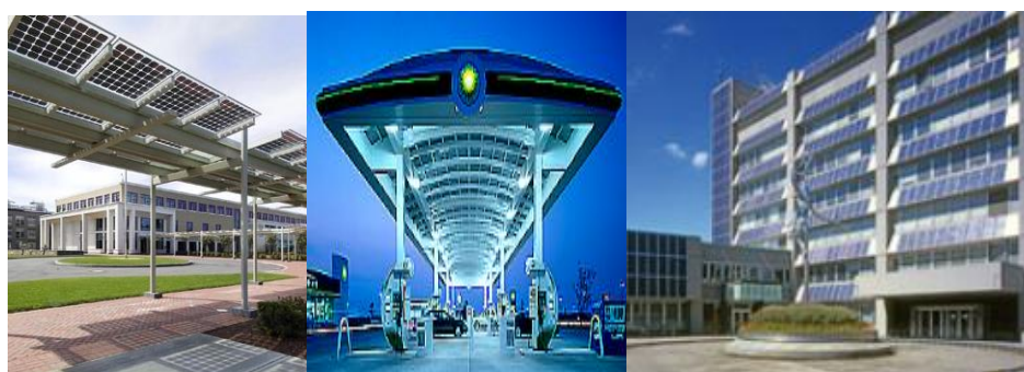
Kuva 3-4. Aurinkopaneelit jalankulkukatoksen ja huoltoasemankatoksen päällä sekä rakennuksen seinään integroituna. [Lähde: Solar design associates]
