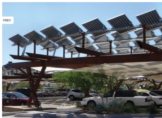
Kuva 3-13. 2-puolisia käännettäviä aurinkopaneeleja parkkipaikan päällä. Heijastavat kankaat tehostavat alapuolelta tulevaa säteilyä. [Kuva: Logan Granger, SunPower Corp., Steve Proehl]
