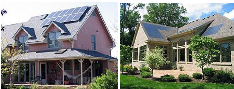
Kuva 3-3. Aurinkoenergiapaneeleja ja ohutkalvotyyppisellä aurinkopaneelimateriaalilla päällystettyjä kattotiiliä omakotitalojen katoilla. [Lähde: NREL]
