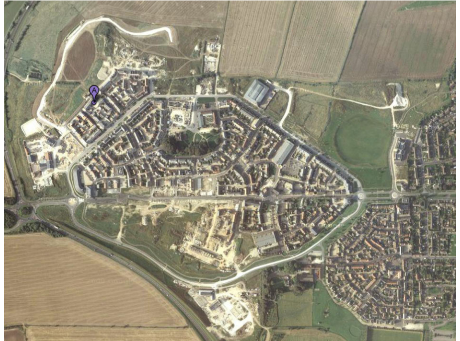
Kuva 5. Googlen ottama ilmakuva Poundburystä (1.9.2010).
