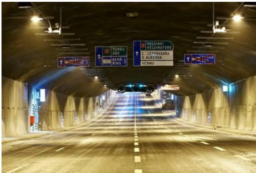
Kuva 1 Toinen Mestarintunnelin ajotunneleista. Kuva: automerkit.fi
