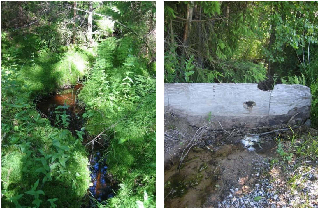
Kuva 17. Kapeaa ja kasvillisuuden ympäröimää uomaa moottoritien ja Storträskin väliltä (vasen kuva), vaneripato moottoritien pohjoispuolella olevassa pelto-ojassa (oikea kuva).
