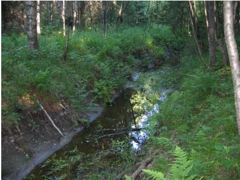
Kuva 22. Kaivettua uomaa Kurängenissä.
