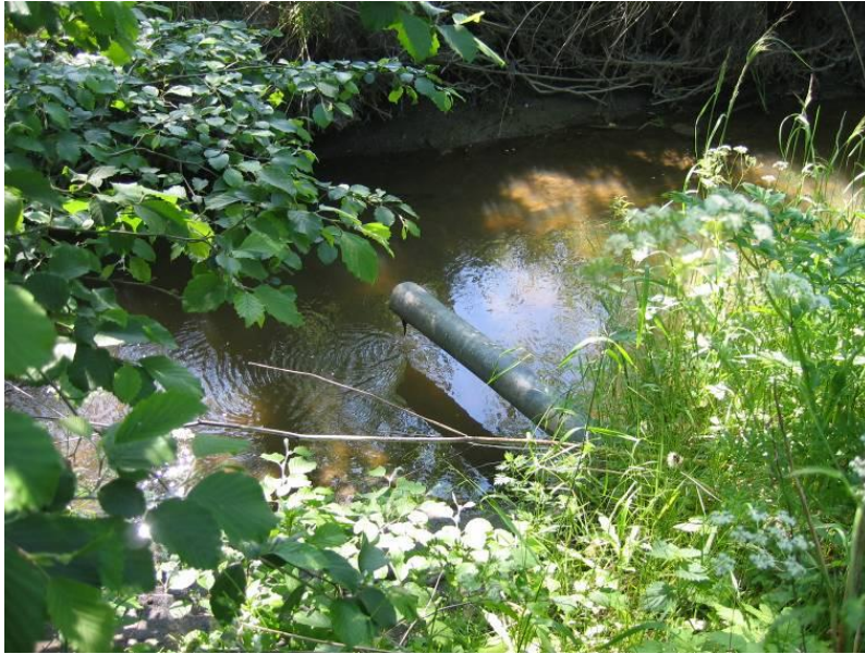
Kuva 18. Viemäriputki teollisuusalueen vieressä.
