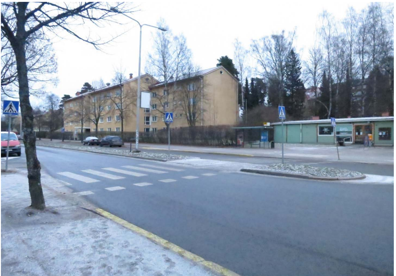
Kuva 18. Suojatien havaittavuutta voidaan parantaa suojatiemerkkien varsiin lisättävillä heijastimilla.
