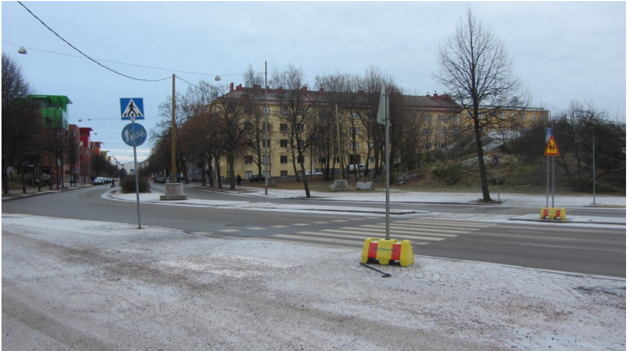
Kuva 10. Aleksis Kiven kadun ylittävä suojatie olisi hyvä poistaa heikon havaittavuuden ja Savonkadun liikennevaloliittymän läheisyyden vuoksi.
