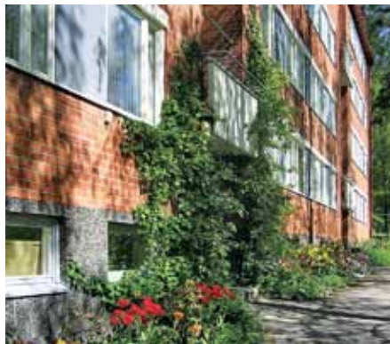
As Oy Kanneltie 5:n pesubetonisokkeli ja puhtaaksi muurattu punatiilijulkisivu.
