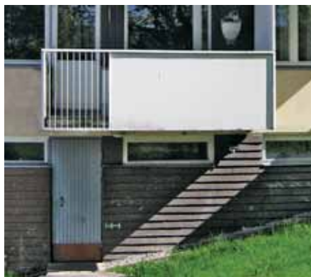
As Oy Rm-talo 59:n sokkeleissa on hieno paikallavalettu vaakasuuntainen kohokuvio.
