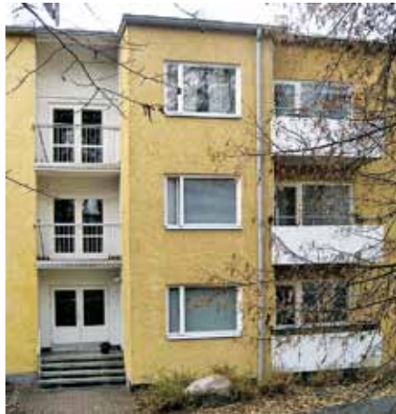
Alla As Oy Kanneltie 9:n tyypilliset tuuletusparvekkeet teräspinnakaiteineen ja huoneistoparvekkeet, joissa Beto-levykaiteet.
