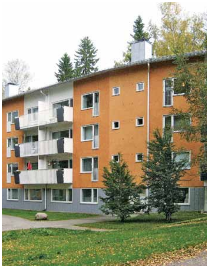
Bostads Ab Bölegårdin julkisivut on maalattu alkuperäiseen sävyyn ja parvekkeet korjattu rakennusten alkuperäinen ilme säilyttää.
