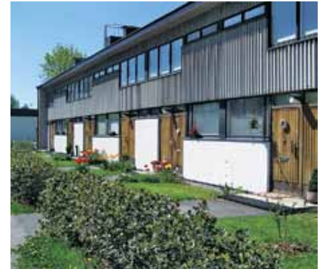
As Oy Säästöörivin julkisivuissa on käytetty ajalle tyypillistä asbestisementti- eli mineriittipoimulevyä.
