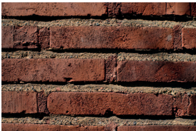
Punainen pystysauma ja vaalea viistottu vaakasauma korostavat tiilipinnan vaakasuuntaisuutta. Rakennuksille vahvasti luonnetta antava muurattu julkisivu. Maunulan Kansanasunnot Oy
