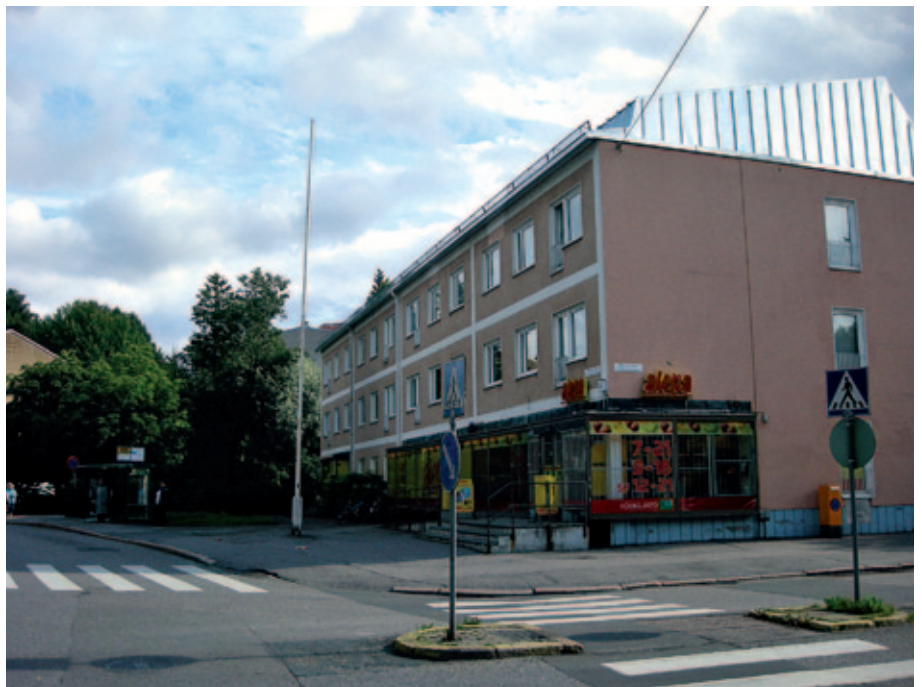
Metsäpurontie 23 toteutettiin betonipilarirunkoisena. Välipohja- ja huoneistojako heijastuu julkisivun suuruusdukkokuviossa.
