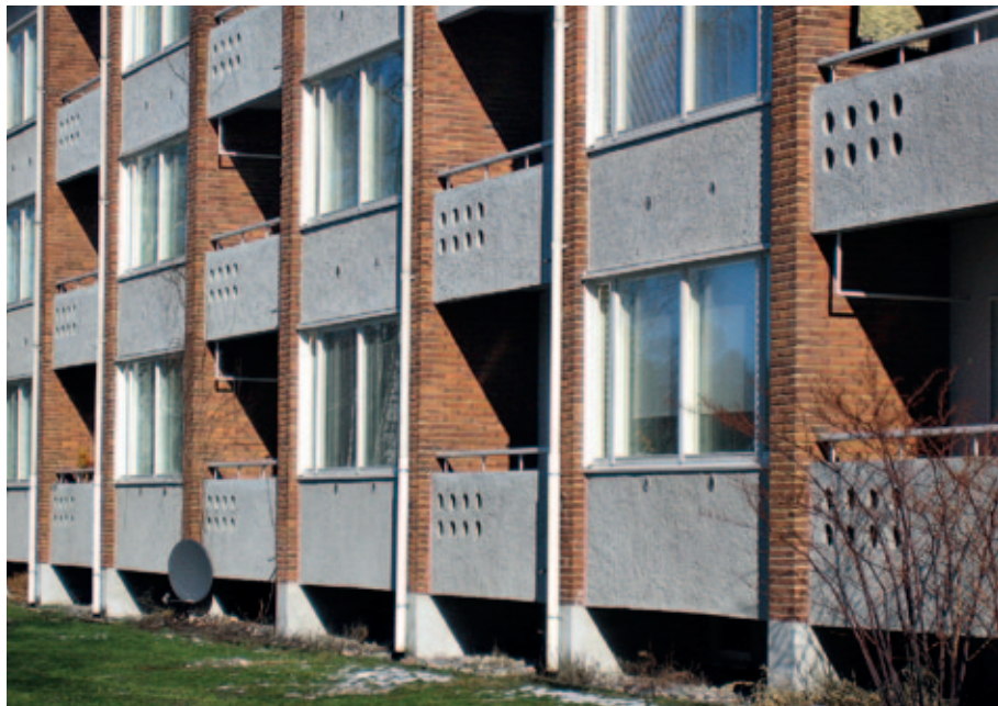
Puhtaaksimuuratut kantavat väliseinät näkyvät julkisivussa pystyinä, seinäpinnasta ulostulevina pilasteriaiheina korostaen rationaalisuutta ja järjestelmällisyyttä. Parvekkeiden rei'itetty betonielementtikaide on osa julkisivurakennetta. Maunulan Kansanasunnot Oy.
