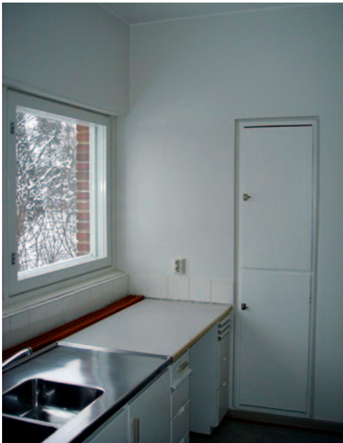
1950-luvun asuunsa korjattu keittiö Vesakkotiellä. Keittiön työskentelytilan edessä on iso maisemaan avautuva ikkuna. Alkuperäiset komerot ja kaapistot on säilytetty peruskorjauksessa osana asuntojen tunnelmaa. Maunulan Kansanasunnot Oy. Arkkitehtitoimisto B.Erat /S.Lönnqvist.
