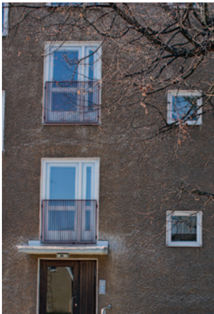
Rapatun julkisivun jäsentelyä Maunulassa. Erityispiirteenä tuuletusparvekkeen punainen ohut pinnakaidelevy sekä valkoiset ikkunanpuitteet.
