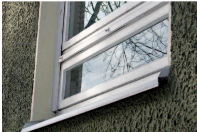
Ikkunan smyygi ja sileän rappauksen liittyminen ympäröivän seinäpinnan karkeampaan roiskerappaukseen.
