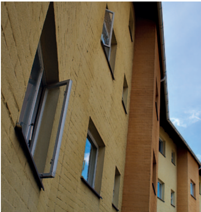
Alkuperäinen ulosaukeava puuikkuna.
