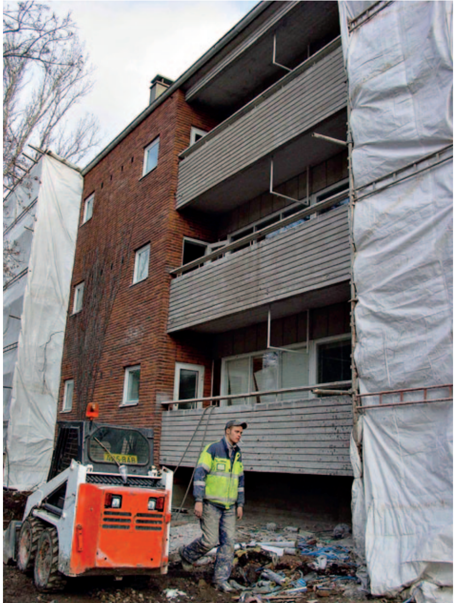
Jokainen rakennus ympäristöineen on kokonaisuus, jonka ominaispiirteet tulee tunnistaa ennen korjaustöihin ryhtymistä. Karhea muottilaudoituksen jälki parvekelevyn betonielementin pinnassa on osa modernin estetiikkaa eikä sitä tule hävittää ylimaalaamalla tai slammaamalla.
