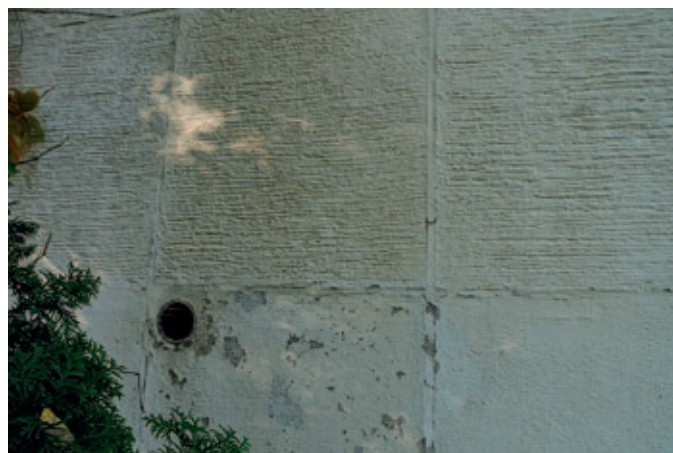
Osa Koivikkotie 12:n julkisivuelementtiä. Korjauksessa vaalittaviin teijöihin kuuluvat elementtijako sekä rappauspinnan hienostunut viivakuviointi.
