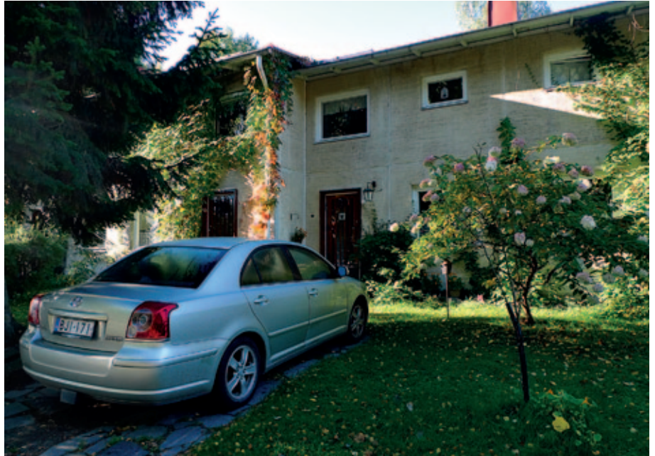
Koivikkotie 14:n julkisivun ikkuna-aukotos perustuu reikäelementtiin. Seinärakenteena on betonielementteihin perustuva kuorirakenne. Koivikkotie14.
