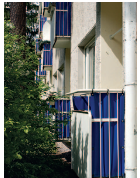
Parvekekaiteen suojana oleva sininen markiisikangas on tärkeä parvekejulkisivun yksityiskohta, joka korostaa kolmiulotteisuutta julkisivussa.
