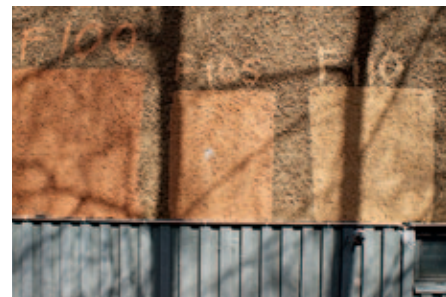
Oikean värisävyn testausta rappauspinnassa. Testattavan pinnan tulee olla riittävän laaja.
