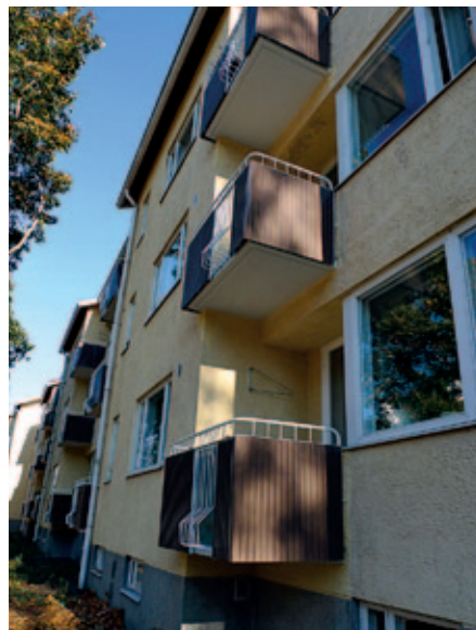
Parvekkeen yksityiskohta. Umpinaista kaidelevyä jäsentää valkoinen pystypinnakaiteen osa, joka on alaosastaan taitettu.
