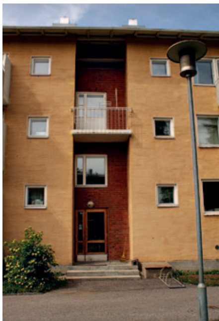
Rakennusten sisääntulo erottuu koko julkisivun kor-kuisella tiilimuuratulla syvennyksellä.
