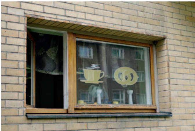
Lakatut puunväriset puitteet ja harmaaksi maalatut karmit. Julkisivun tiilimuuraus jatkuu ikkunasyvennyksessä.
