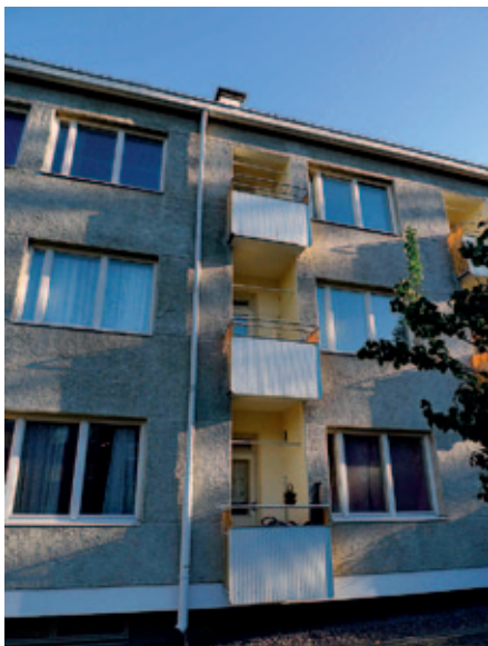
Nurkistaan pyöristetty pystyuritettu ohut parvekekaide, parvekkeen sivuilla markiisi.
