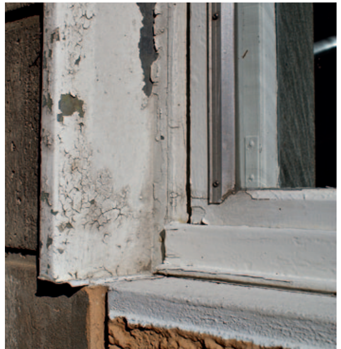
Ikkunan ja seinäpinnan liittymäkohta.
