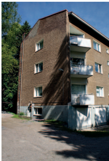
Sisäänvedetty olohuoneen ikkuna yhdessä ulokepar-vekkeen kanssa avaa asunnosta näkymän kahteen suuntaan.
