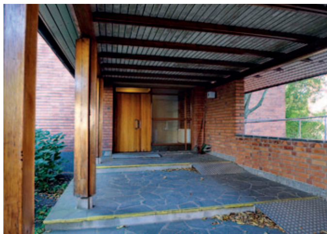
Katoksen alle sijoitettu rakennuksen sisäänkäynti on kokonaan liuskeketetty. Porrashuoneeseen jatkuva punatiilinen julkisivupinta korostaa yhteyttä ulko- ja sisätilan välillä.
