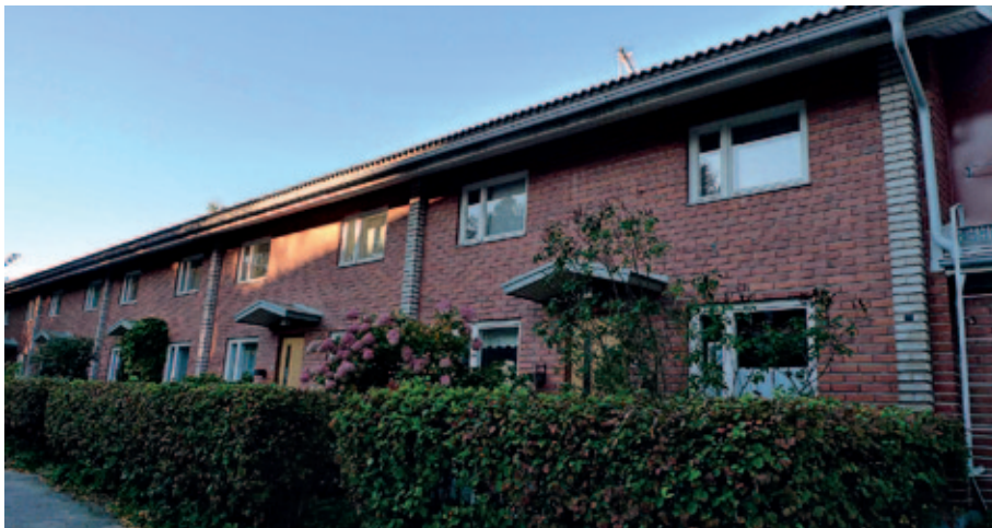
Koivikkotie 30, arkkitehti Matti Haapala. Jakavien huoneistoseinien päädyt näkyvät julkisivussa pystyjakona. Sisäänkäyntien yhteydessä on kolmion malliset betoniset katoslipat.
