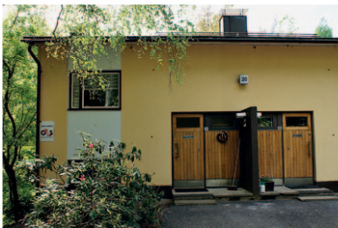
Sisäänkäynnit on järjestetty julkisivuun aina pareittain. Ulko-ovina ovat lakatut puupaneeliovet, joissa on kapeat vaakasuuntaiset tumman ruskeaksi maalatut yläikkunat.
