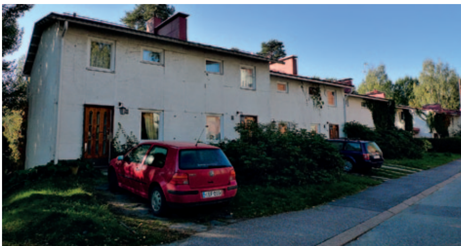
Elementtilevyihin perustuvien julkisivujen pintaa elävöittää viivarappaus. Rakennuksen ikkunasommittelu ja aukotus perustuu tatamin mittoja noudattavaan elementti-jakoon. Koivikkotie 12, arkkitehti R. Lanste 1955.
