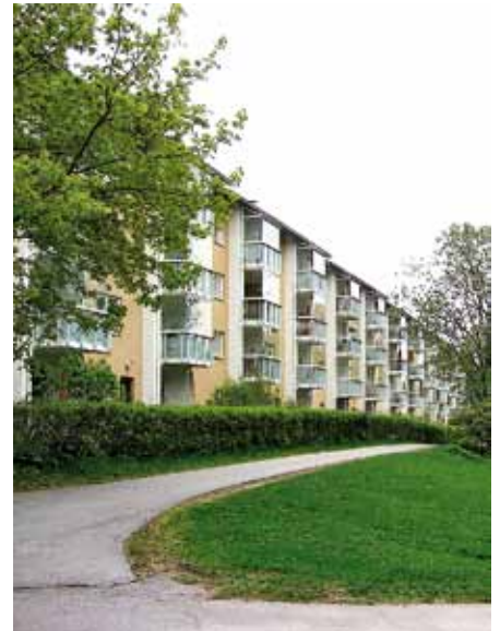
34. Pohjois-Haagan Kiinteistöt Oy / Ohjaajantie 11. Parvekkeet on uusittu 2003, kaidemateriaali on vaihdettu vaakalautoituksesta lasiksi.
