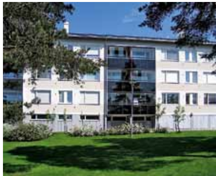
12. As Oy Näyttelijäntie 24:n parvekekaiteet on uusittu. Kohteiden 12 ja 13 julkisivuissa on käytetty eri värisiä ja struktuuriltaan erilaisia nauhamaisia rappauspintoja.
