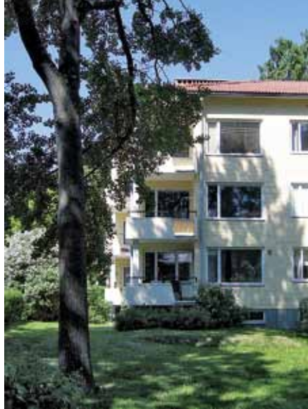
39. As Oy Jussinkulma. Julkisivut on Pohjois-Haagassa epätyypillisesti slammattu. / Pastori Jussilaisen tie 4.
