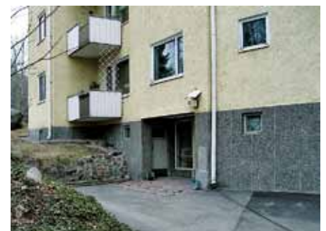
As Oy Pohjois-Haagan Pistetalot I:ssä on sokkeleissa käytetty uritettua mosaiikkibetonia / Näyttelijäntie 8–12.
