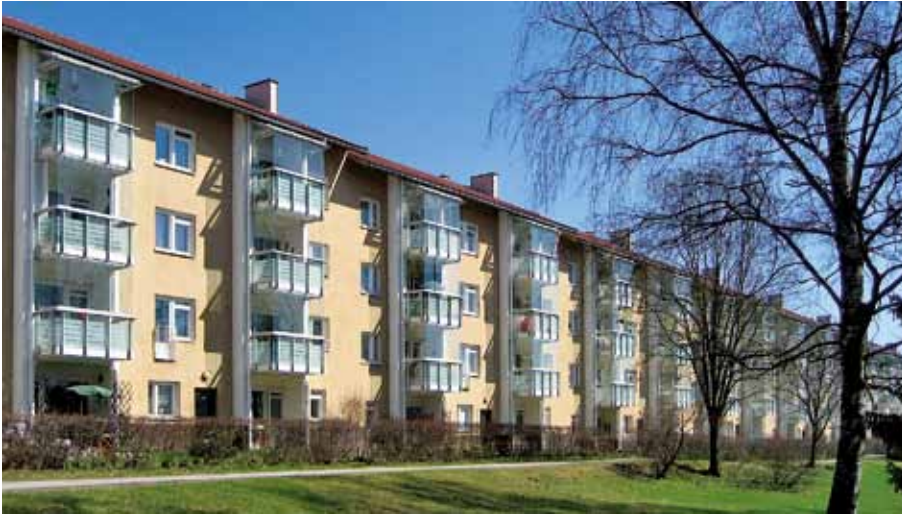
Pohjois-Haagan Kiinteistöt Oy / Ohjaajantie 11, uusitut parvekkeet.
