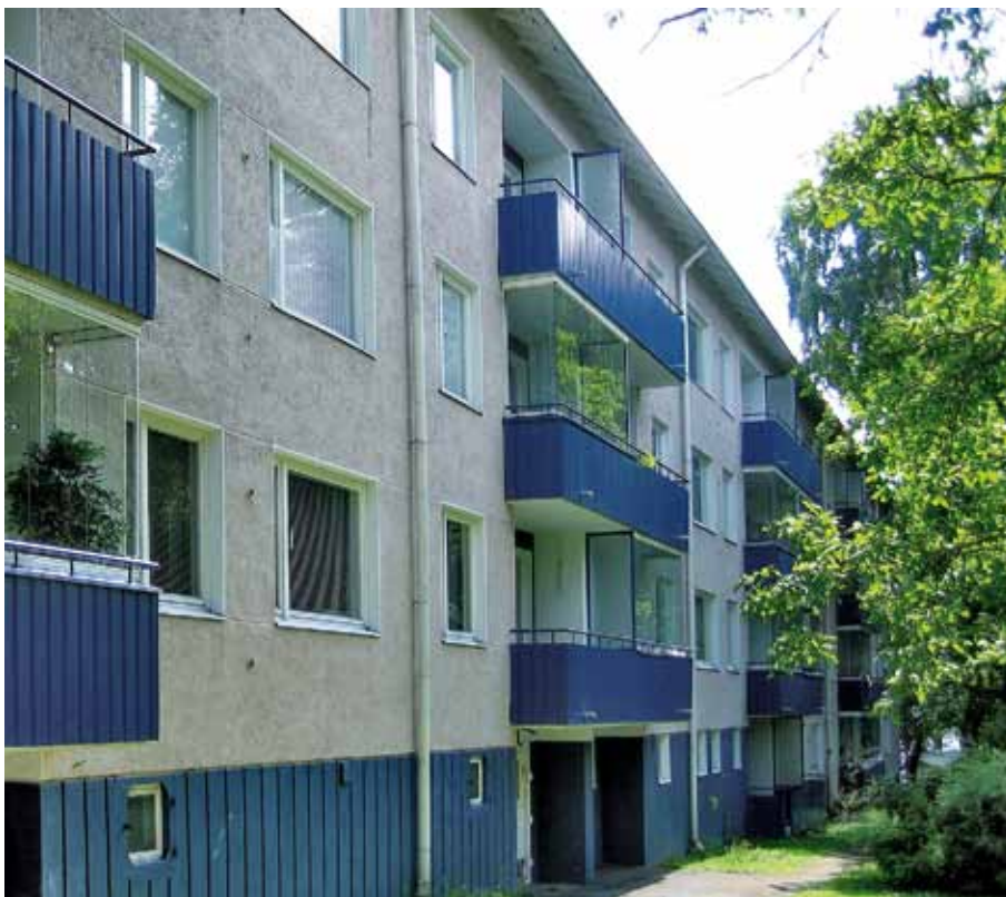
As Oy Näyttelijäntie 16. Maalattut, pystyuritetut sokkelit, rapatut massiivitiilijulkisivut, valkoiset parvekeovet ja puukunat tuuletusikkunoihin sekä ulokeparvekkeet profiilipeltikaiteineen ovat Pohjois-Haagalle tyypillisiä.
