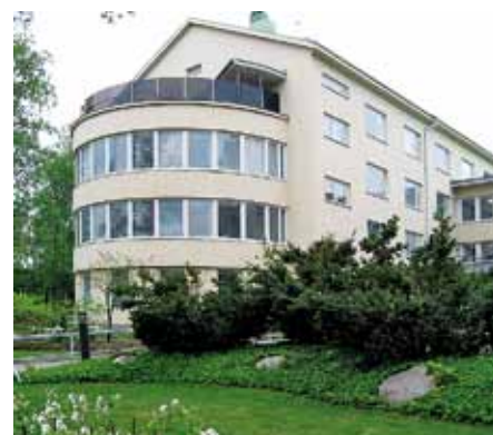
Vanhainkoti Hagaron vuonna 1956 valmistunut suojeltu osa / Tolarintie 2.
