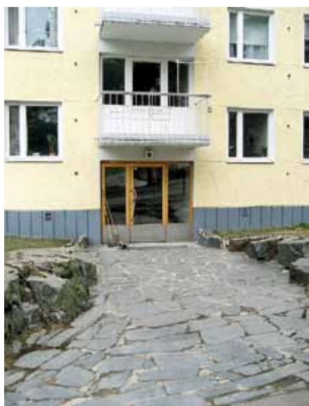
Näyttelijäntien lamellitalon sisäänkäynnin edusta, jossa alkuperäiset pintamateriaalit ovat säilyneet.
