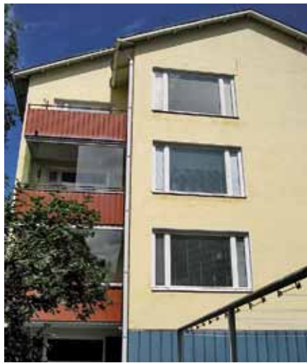
Näyttelijäntien lamellitaloissa ylimmän kerroksen parvekkeita ei ole lasitettu eikä katettu. Katoksen rakentaminen olisi vaikuttanut rakennusten arkkitehtoniiseen ilmeeseen voimakkaasti.
