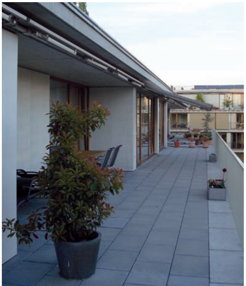
Asuntoihin liittyvät ulkotilat katolla
