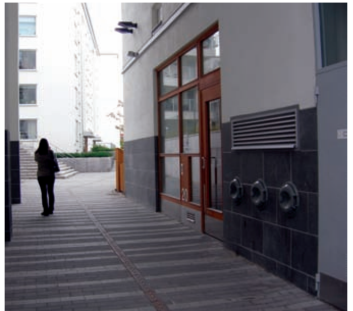
Jätteenkeräysluukut Hammarby Sjöstadissa Tukholmassa
