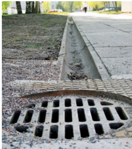
Laatoitettu betonipinta on huonokuntoinen ja vaarallinen jalankulkijoille ja pyöräilijöille.
