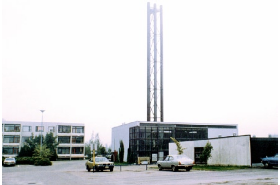
Lämpökeskuksen piiput korotettiin vuonna 1971.
