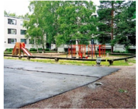
Esimerkki ei-toivotusta tilanteesta, jossa talon kulumissa asfaltti leviää laajalle.
