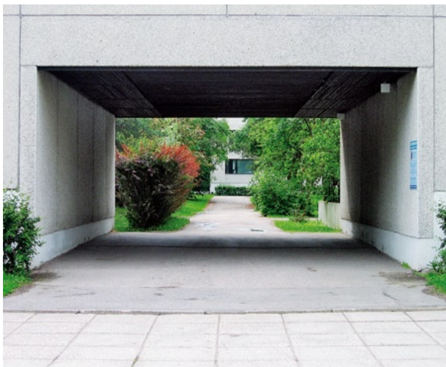
Betonilaatta ja pesubetonijulkisivurakennusten ja lähiympäristön yksiaineisuus.
