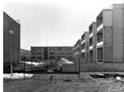
Siltakoivun korttelin työmaa eri vaiheissa.
