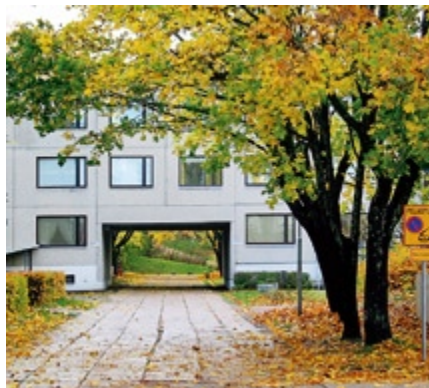
Kauriinpolku. Raitin jatkuminen rakennuksissa olevien aukkojen läpi korostaa raitin perspektiivivaikutelmaa sekä eri osa-alueiden kytkeytymistä toisiinsa.
