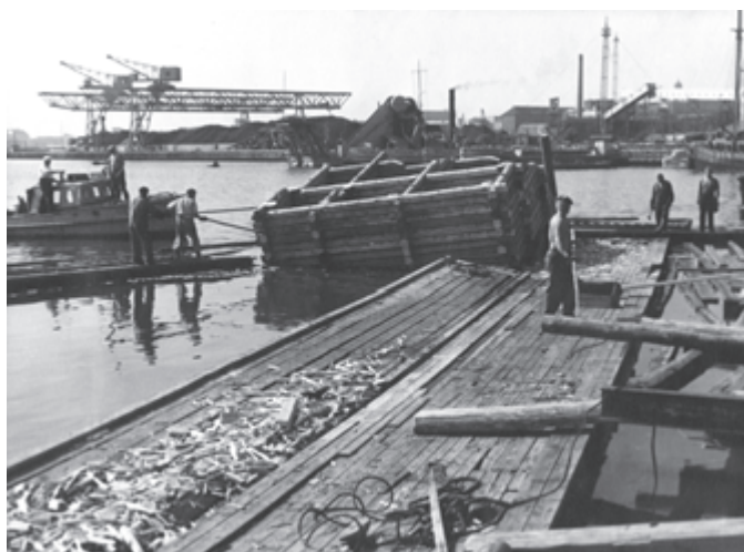
Sörnäisten satama, silta-arkun työmaa 1955
