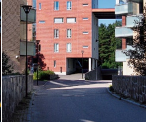
Mosaikstråket med sina tunnlar och murar bildar en enhetlig del av bostadskvarterets arkitektur i kvarteret Eden i centrum av Nordsjö.
