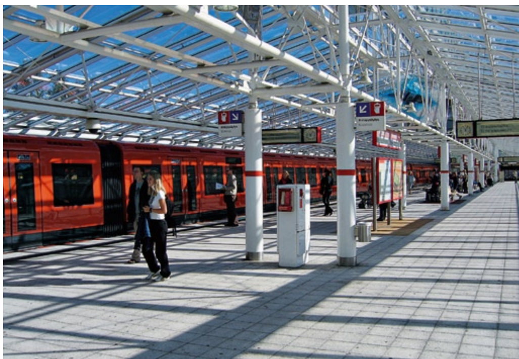
Nordsjö metrostation. Metron började köra till Nordsjö 1998. Arkitektbyrå Esa Piironen Oy, 1998.
