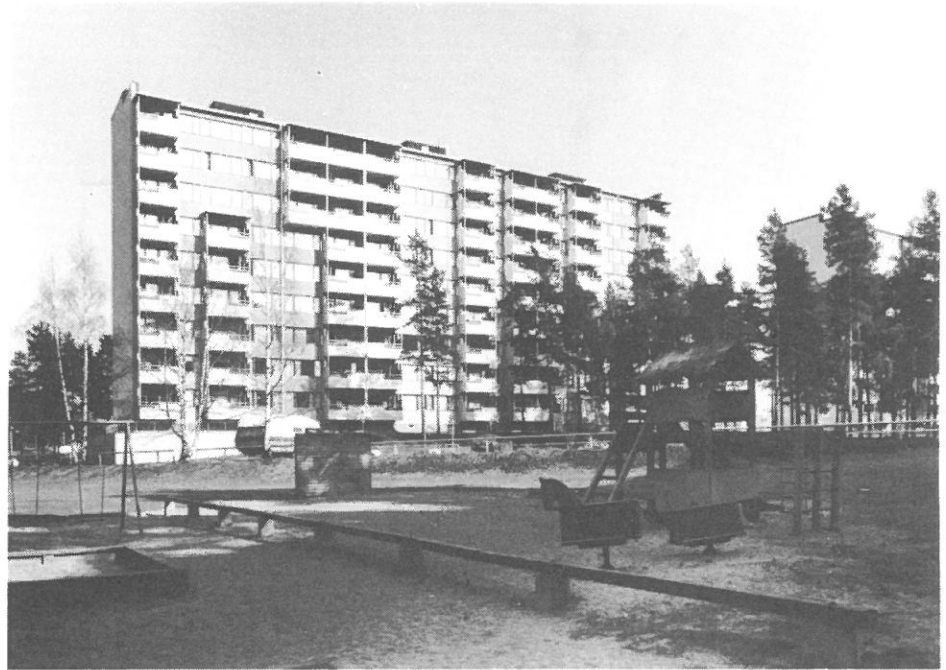
Ostostie. Uudet parvekkeet. Kuva Pia Pärevalo.
