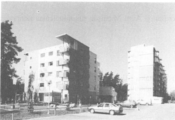
Ostostie 1-5. Uudisrakennus ja peruskorjaus. Kuva Pia Pärepallo.
