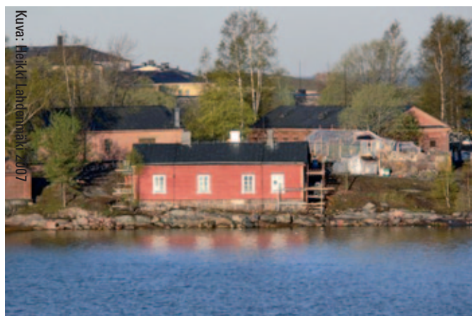
Hirsinen miinalaboratorio- ja asuinrakennus Lonnan koillisrannalla kunnostettiin hiljattain
