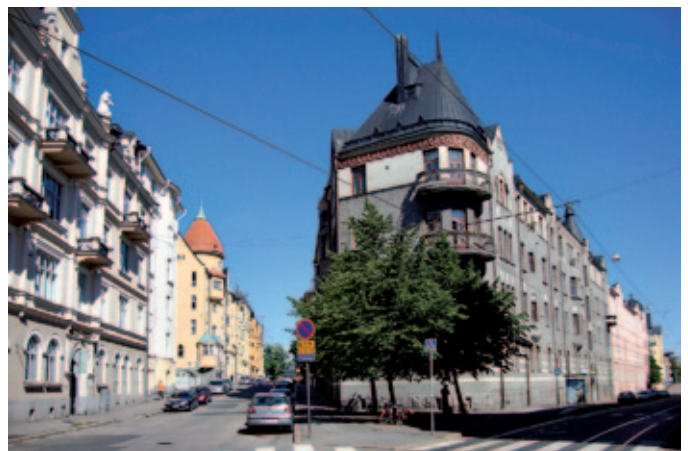
Vanhan osan jugendkerrostalot muodostavat rakennushistoriallisesti arvokkaan aluekokonaisuuden johon ei juurikaan kohdistu uudisrakennushankkeita
