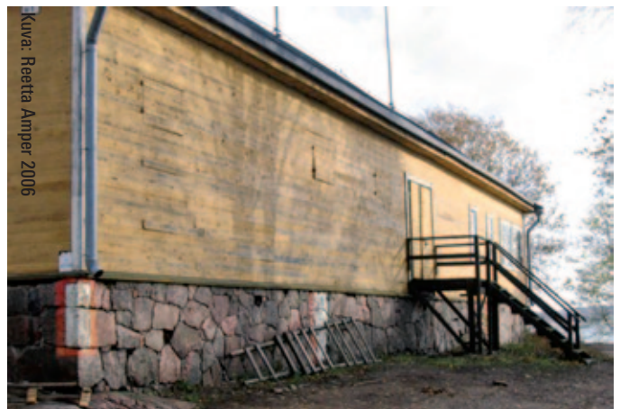
Alun perin vuonna 1837 ammusvarastoksi tehty puinen makasiini on vanhin saarella säilynyt rakennus. 1940-luvulta 1970-luvulle asti se toimi laivojen demagnetointiasemana
