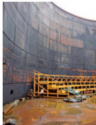
Öljysäiliörakennelman ruostuneiden seinien sisään on rakennettu kesäte- atterilava A summer theatre stage has been built inside the rusty walls of the oil tank structure
