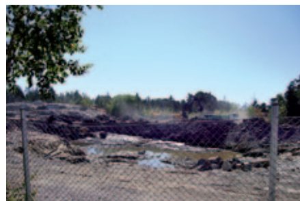
Satama-alueella suoritetaan maanpuhdistusta, jotta uudisrakentaminen voidaan aloittaa 2012 Ground cleansing is being performed in the harbour area in order to start new construction in 2012
