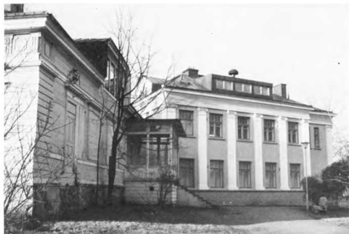
A, B. Tilan päärakennusryhmä, nykyisin huvila 21, Bredablick: Empire-tyylinen puurakennus, lajinsa ainoita jäljelläolevia (Y)
