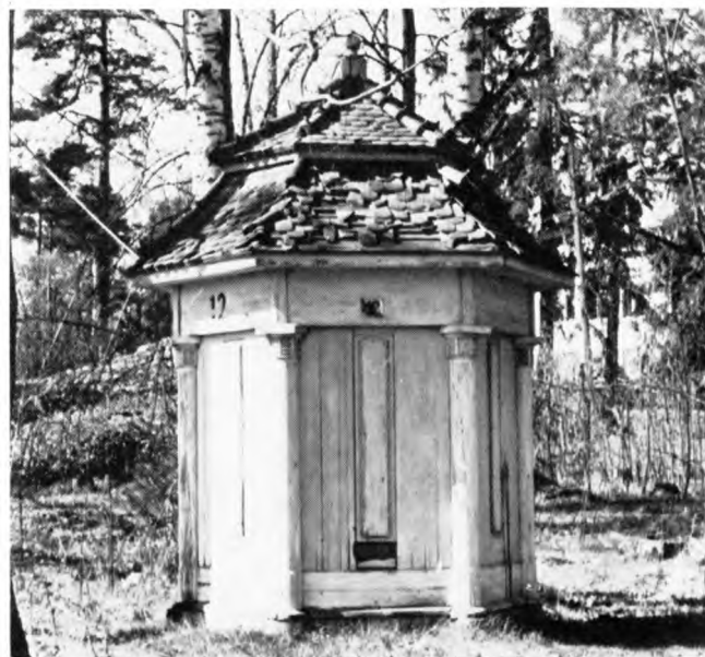
D. Huvilan 12 kaivo
