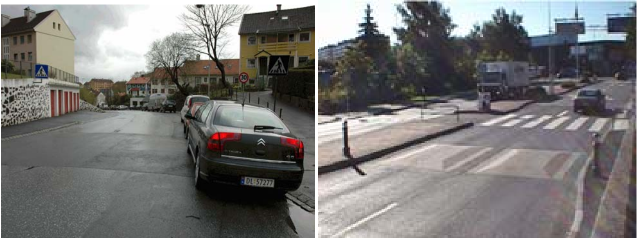
Kuva 31: Bergenin asfalttitöyssy ja Ruotsissa kehitelty betonielementti.
