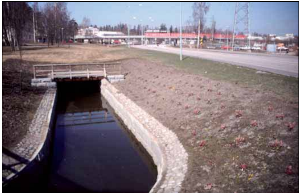
Kuva 43. Mellunkylänpuro Kontulantien ja Länsimäentien alituksen jälkeen 3 .
