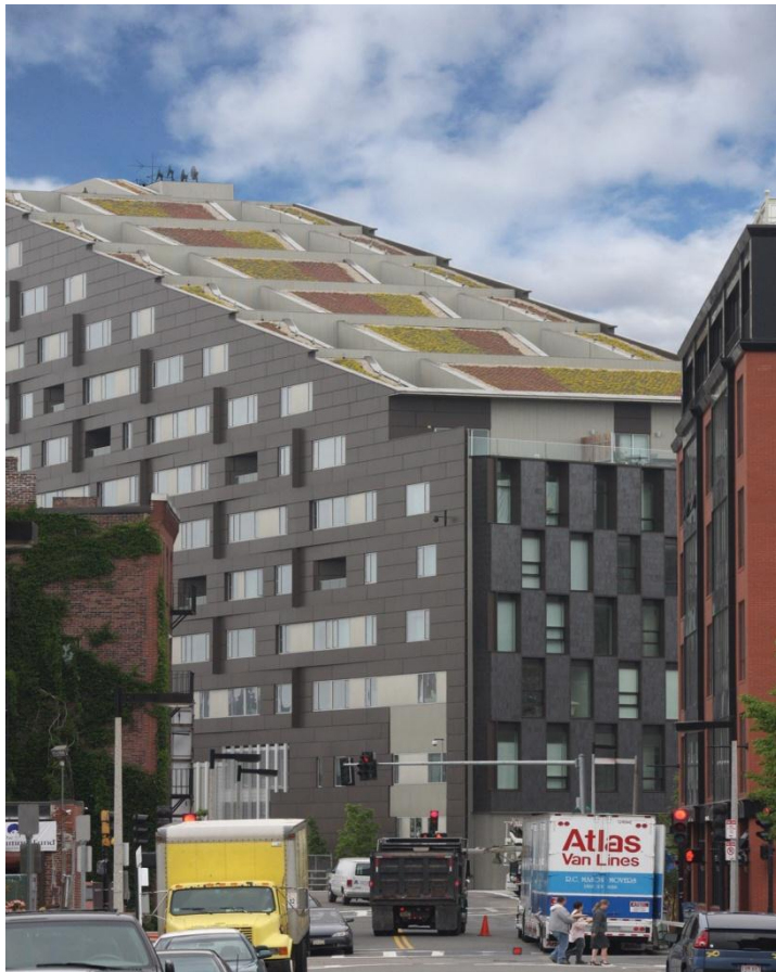
Kuva 10. Kaltevalle katolle perustettu viherkatto. (American Hydrotech 2013b)
