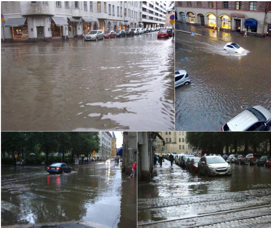
Kuva 26. Kuvia Kapteeninkadun ja Tehtaankadun risteuksen tulvimisesta 22.8.2011. Vesi on noussut kuvien perusteella noin 40 cm kadun pinnan yläpuolelle.
