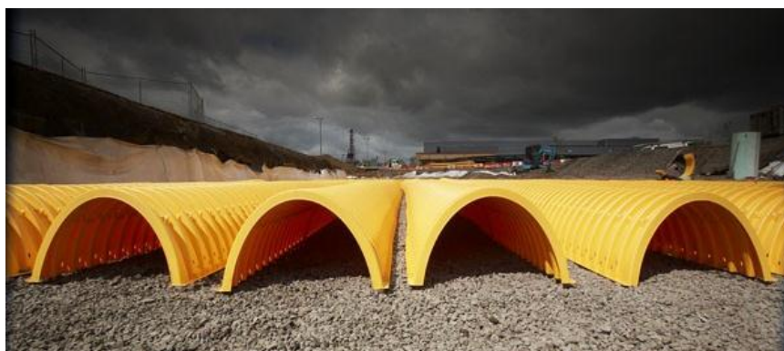
Kuva 6. Putkimainen hulevesien viivytyks- ja imeytysrakente. Putken korkeus on noin puolitoista metriä. (StormTech 2012)
