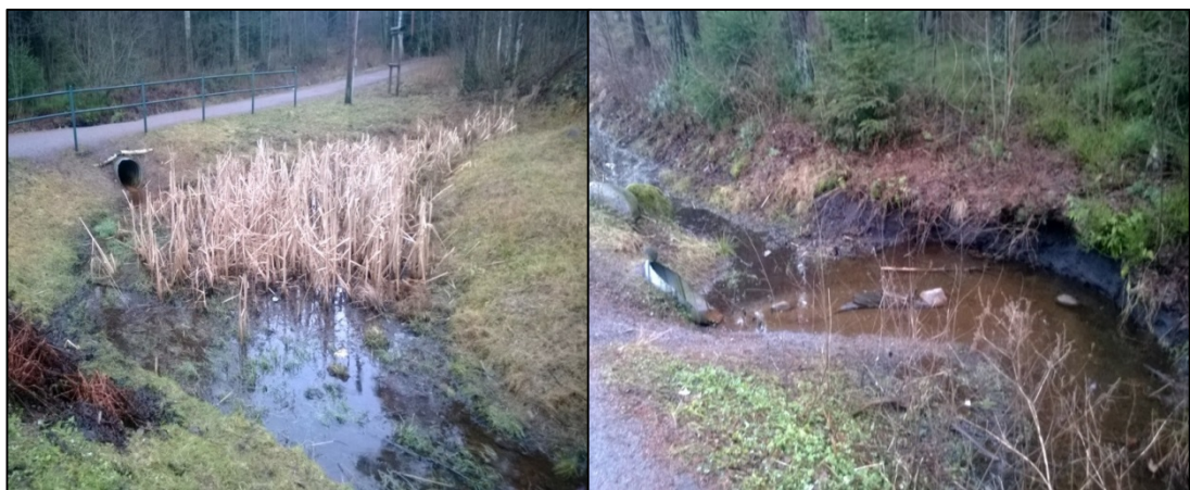
Kuva 46. Uoman laajennus ja rumpu ulkoilureitin ali Ruutipuiston itäosassa. Rummun jälkeen virtaus kovertanut penkkää.
