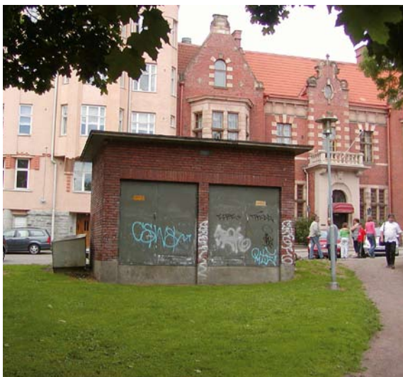
Kuva 35. Tiilirakenteinen muuntaja esiintyy sodan jälkeisessä suunnitelmissa ensimmäisen kerran. KU 2005.
