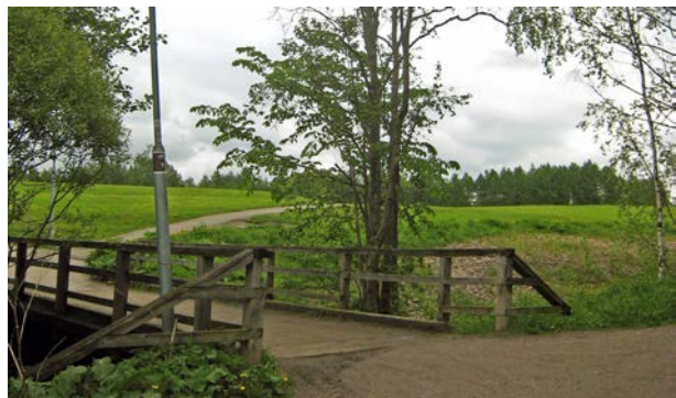
KUVA 37 Sillan vierelle istutetaan uusi puu uoman toiselle puolelle. Sillan kunto tulisi tarkistaa.
