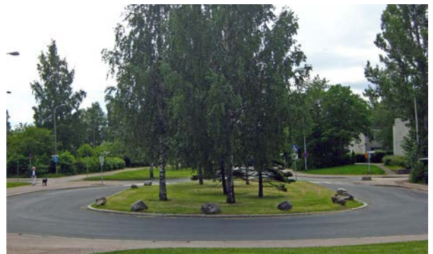
KUVA 113 Bussien kääntöpaikalle on oikomisen vuoksi asetettu kiviä. Ympyrässä kasvaa koivuja ja kaksi huonokuntoista pihkaa.
