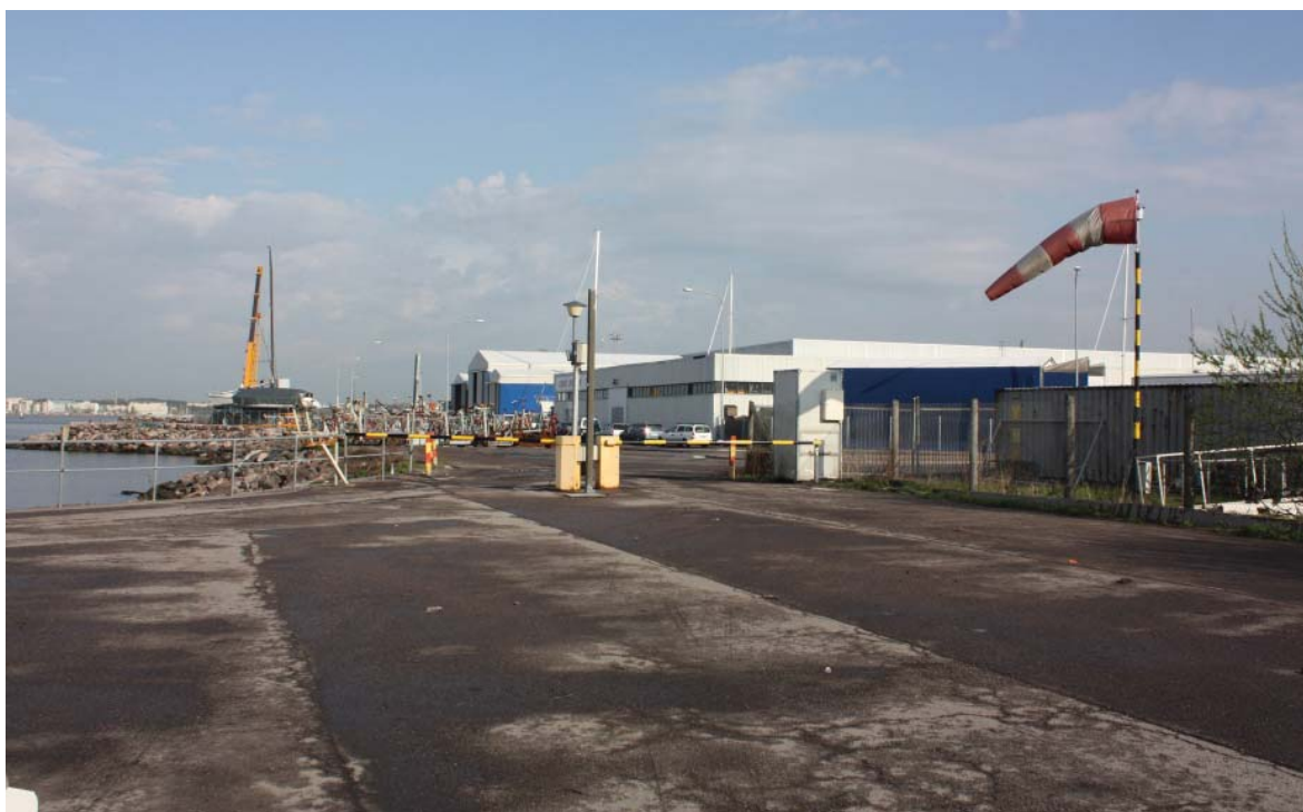
Kuva 6. Hernesaaren vastaanottoaikan sisääntuloportti (toukokuu 2010)
