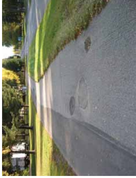
Kuva 40. Kuoppa, ei reunakiveä Mellunkyläntiellä.
