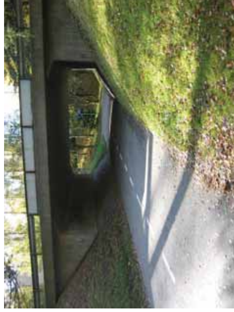
Kuva 49. Alikulkukäytävä Mellunkyläntien ali, ajojohteet ruostuneet.
