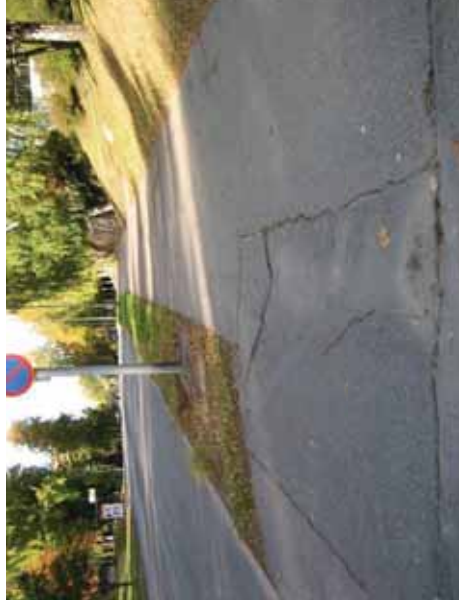
Kuva 46. Juuret rikkovat päällysteen Mellunkyläntiellä.
