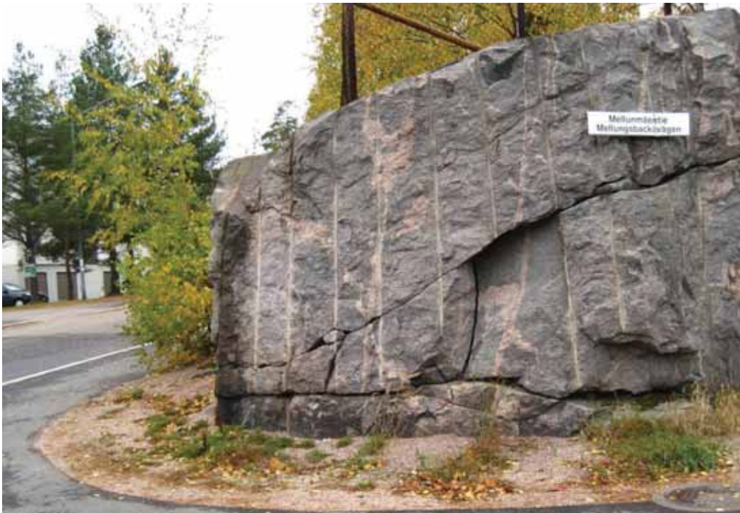
Kuva 22. Kallioleikkauksen tyvi on epäsiisti Kaunispääntien liittymässä. Katuvihreän inventointikartalla kuva nro 45.
