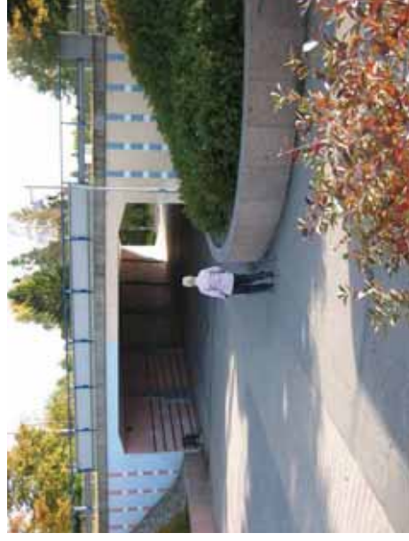
Kuva 49. Alikulkukäytävä Mellunkyläntien ali, ajojohteet ruostuneet.
