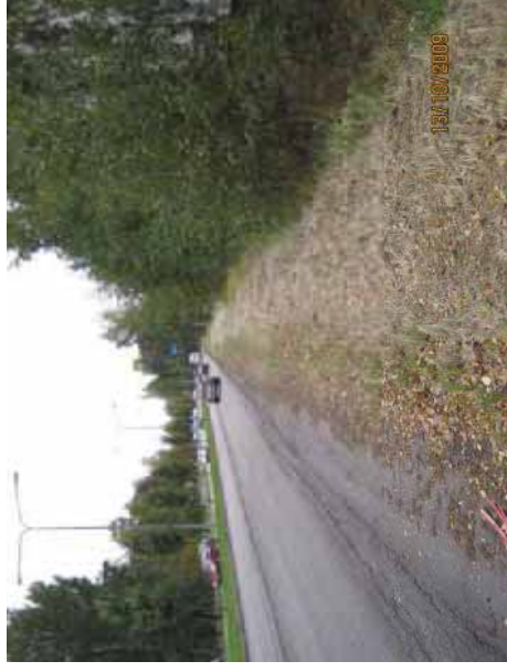
Kuva 1. Kadulta valuvat vedet ovat pilanneet nurmikon.
