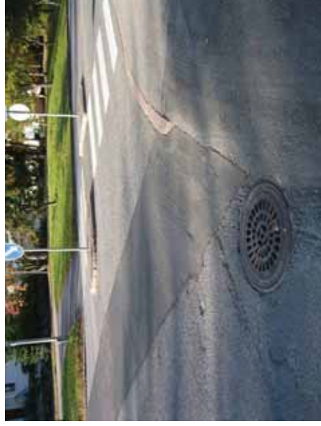
Kuva 33. Reunakivi puuttuu Mellunkyläntieltä
