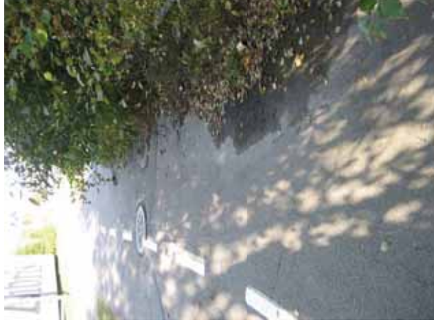
Kuva 27. Huonosti viimeistelty johtotyö Mellunkylän-tiellä.
