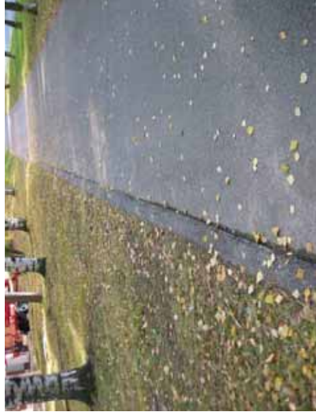
Kuva 43. Painumaa kaivon vieressä Mellunkyläntien kevyen liikenteen väylällä.
