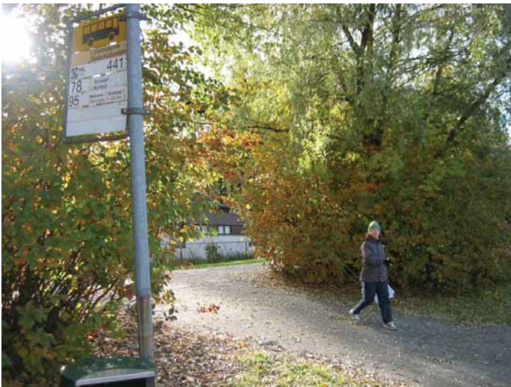
Kuva 12. Länsimäentien pysäkiltä on puutteellinen näkemä kevyen liikenteen väylälle ja ajoradalle sekä päinvastoin. Inventointikartalla nro 17.
