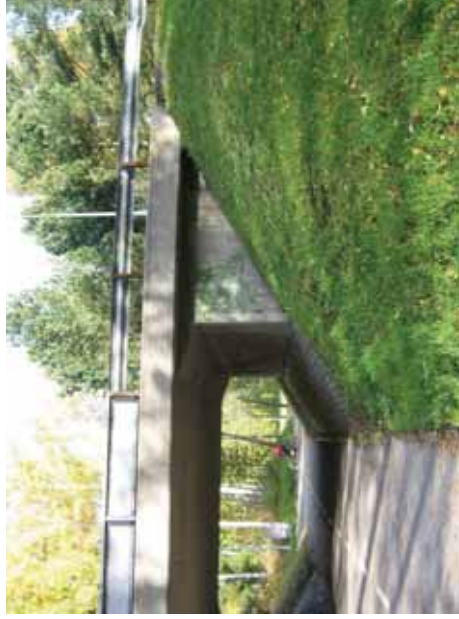
Kuva 48. Ajojohteet ruostuneet.
