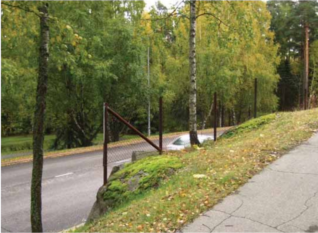
Kuva 21. Suoja-aita on ruostunut. Katuvihreän inventointikartalla kuva nro 40.
