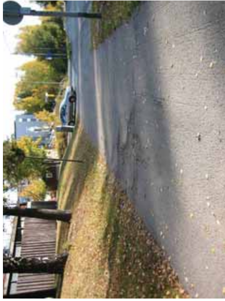
Kuva 46. Juuret rikkovat päällysteen Mellunkyläntiellä.
