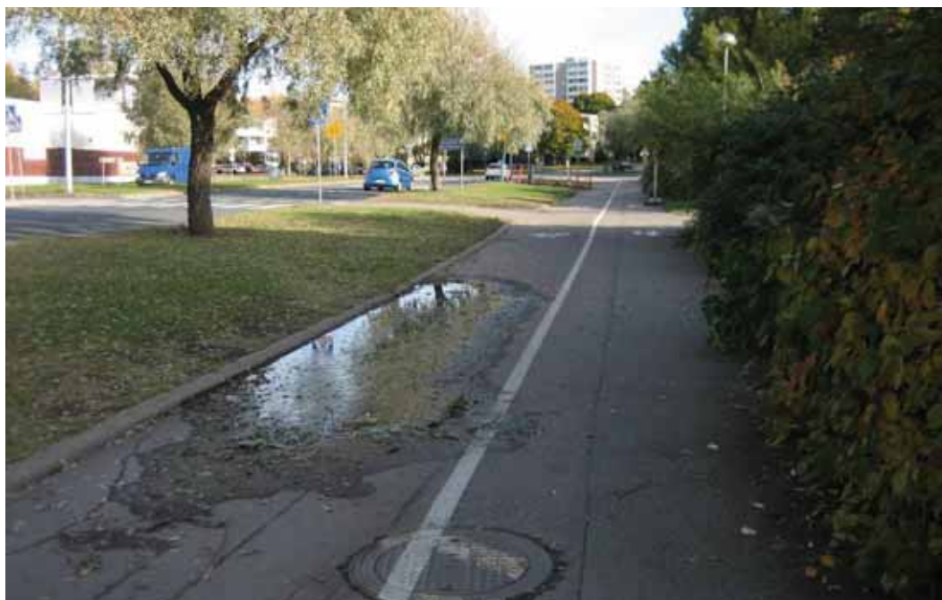
Kuva 9. Sadevesi kerääntyy painumaan ja muodostaa kulkumukavuutta häiritsevän lätäkön Mellunmäentiellä. Katuinventointikartalla kuva nro 23.
