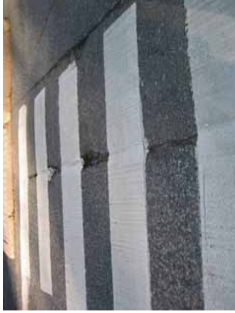
Kuva 27. Huonosti viimeistelty johtotyö Mellunkylän-tiellä.
