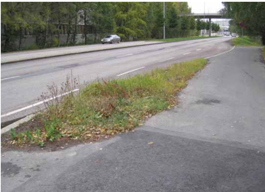
Kuva 15. Kontulantietä pienteollisuusalueen kohdalta. Katuvihreän inventointikartalla kuva nro 5.
