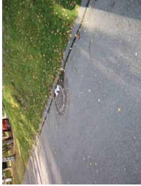
Kuva 43. Painumaa kaivon vieressä Mellunkyläntien kevyen liikenteen väylällä.
