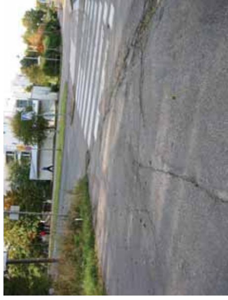
Kuva 33. Reunakivi puuttuu Mellunkyläntieltä
