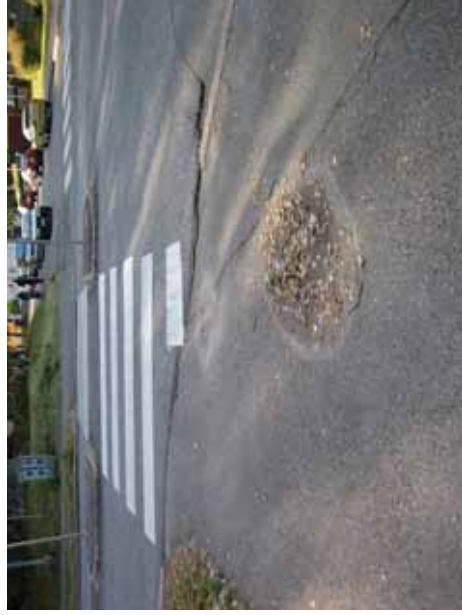
Kuva 40. Kuoppa, ei reunakiveä Mellunkyläntiellä.
