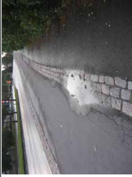
Kuva 14. Kiveys on painunut Kirkonkyläntieltä.
