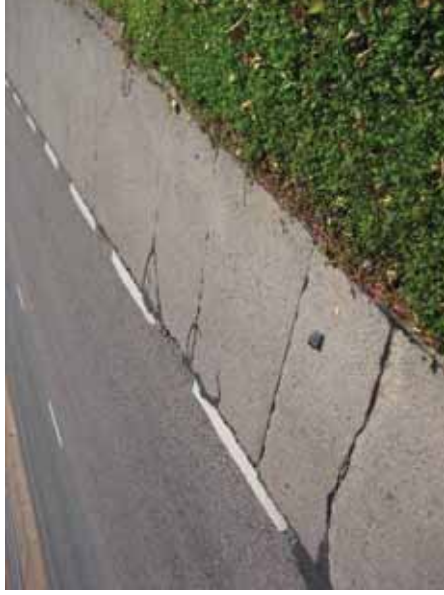
Kuva 25. Halkeamia la-pysäkin kaistalla Kirkonkyläntiellä.
