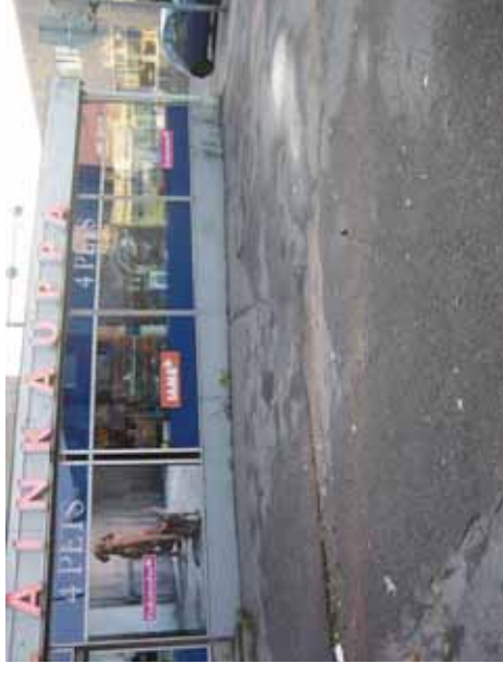
Kuvat 57 ja 58. Epätasaisuutta kadun ja kiinteistön rajalla Malminraitin ja Kirkonkyläntien liittymäalueella.
