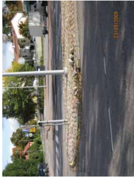
Kuva 8. Purkautumassa oleva kenttäkiveys Latokartanonttiellä Vanhan Tapanilantien kohdalla.
