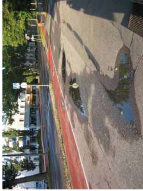
Kuva 53. Vettä kerääviä painanteita Kirkonkyläntien pohjoisen puoleisella kevyen liikenteen väylällä välillä Markkinaraitti - Notkokuja
