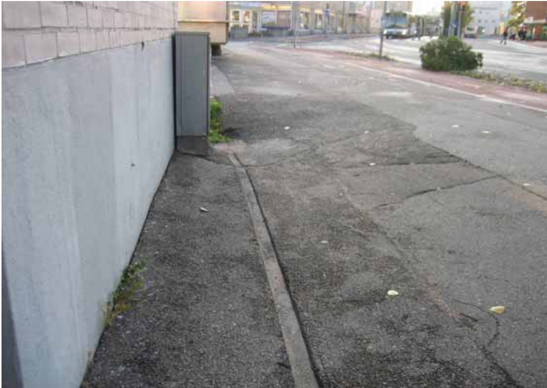
Kuva 9. Kiinteistön ja kevyen liikenteen väylän välillä on tasoero, kuva on otettu Kirkonkyläntieltä läheltä Malmin raitin liittymää, pohjoisen puoleiselta kevyen liikenteen väylältä. Katuinventointikartoilla kuva nro 55.
