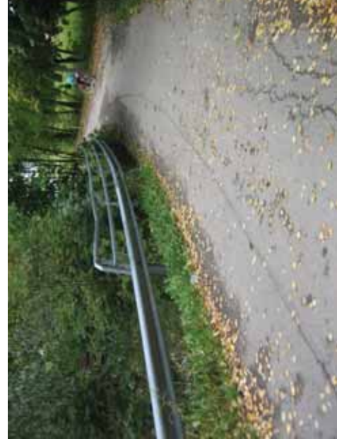
Kuva 84. Turvallisuusriski kaiteen sijaitessa kaukana Latokartanon tien kevyen liikenteen väylän reunasta.
