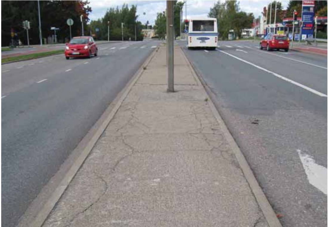
Kuva 21. Betonivalua Kirkonkyläntien keskikaistalla Laulurastaantien liittymässä. Inventointikartalla kuva numero 13.
