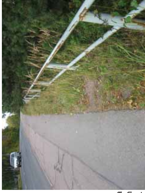
Kuva 85. Ruosteinen kaide, joka sijaitsee liian etäällä päällysteen reunasta Latokartanonttiellä.
