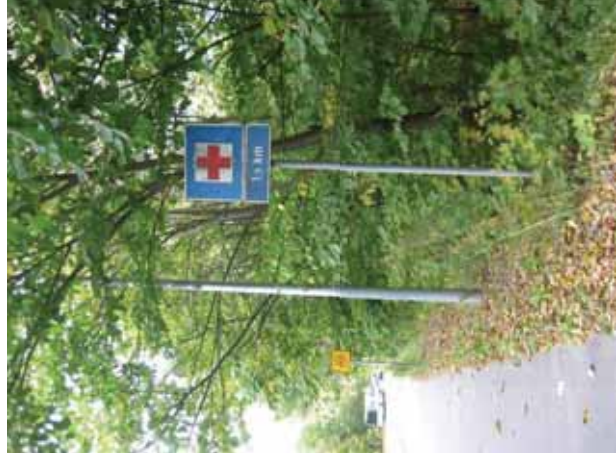
Kuva 91. Haalistunut ja huonosti nähtävissä oleva liikennemerkki,
