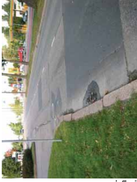
Kuva 28. Ajoradassa epätasaisia paikkauksia ja deformaatiota, kuntoluokka 2.
