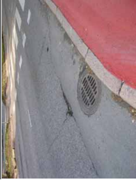
Kuvat 43 ja 54. Sadevesikaivot alhaalla suhteessa Kirkkonyläntiehen.
