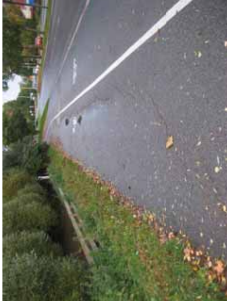
Kuva 2. Reunapainumaa Kirkonkyläntien etelän puoleisella kevyen liikenteen väylällä lähestyttäessä Tapaninvainiontieta, kuntoluokka 3.
