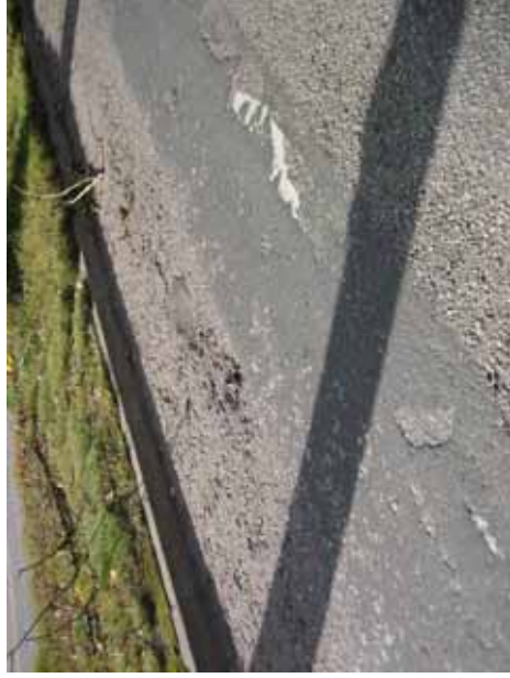
Kuva 30. Kääntymiskaista deformoitunut ja reikäinen Kirkkonyläntiellä.
