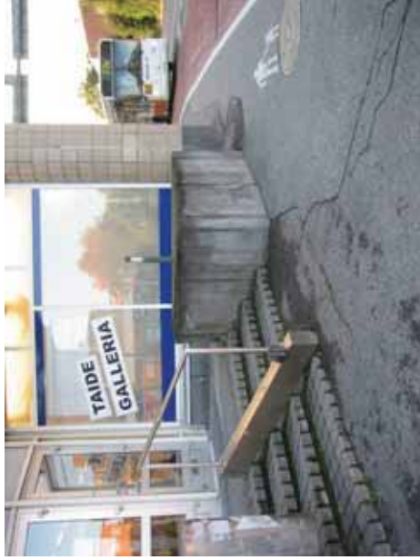
Kuvat 57 ja 58. Epätasaisuutta kadun ja kiinteistön rajalla Malminraitin ja Kirkonkyläntien liittymäalueella.
