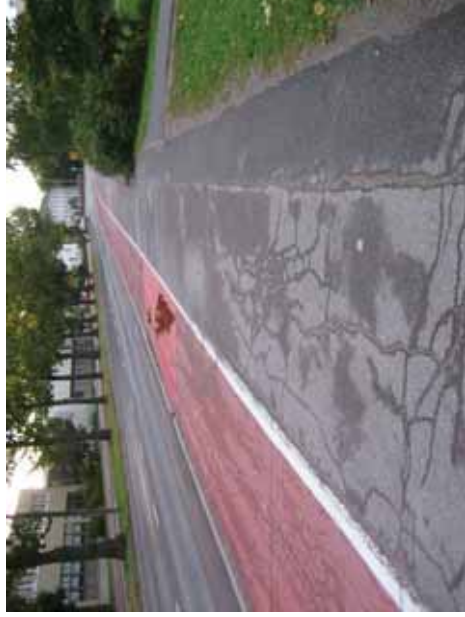
Kuva 29. Yksittäinen vettä keräävä painanne Kirkonkyläntiellä kevyen liikenteen väylällä.
