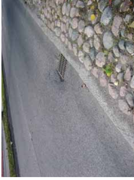
Kuvat 43 ja 54. Sadevesikaivot alhaalla suhteessa Kirkkonyläntiehen.
