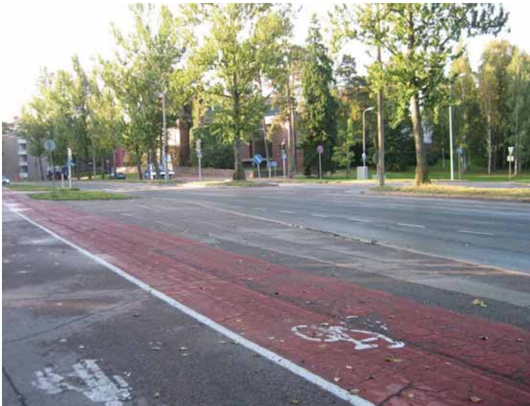
Kuva 5. Kevyen liikenteen väylällä halkeamia, kuntoluokka 2, kuvan oikeassa reunassa näkyy Kirkkonkyläntien ja Malmin sairaalankadun liittymä. Katuinventointikartoilla kuva nro 32 a.
