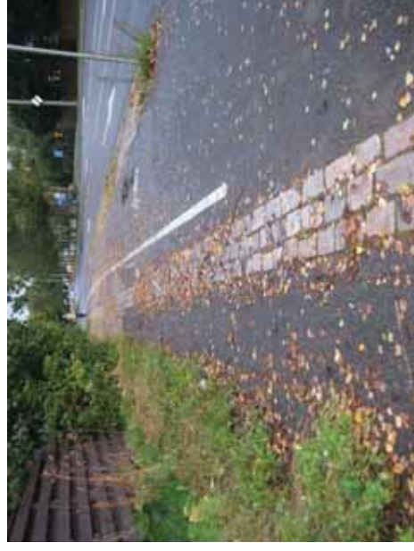
Kuva 9. Kiveys ja maaliivi eri paikassa Kirkonkyläntieltä.
