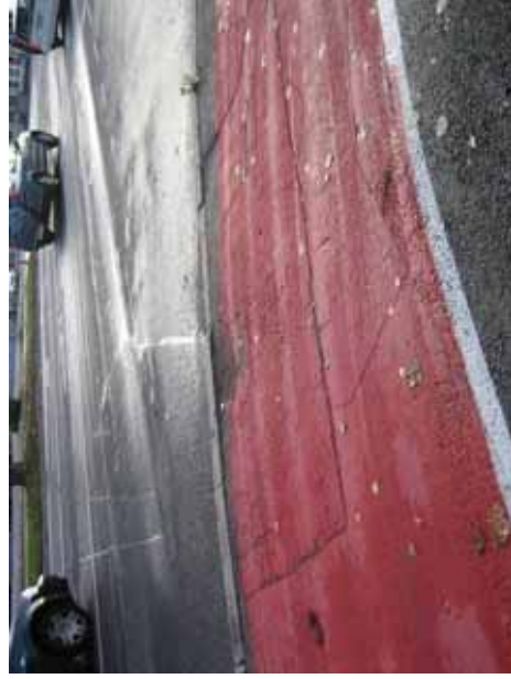
Kuva 52. Kevyen liikenteen väylällä harvaa asfalttibetonia ja kuoppia Kirkonkyläntiellä.
