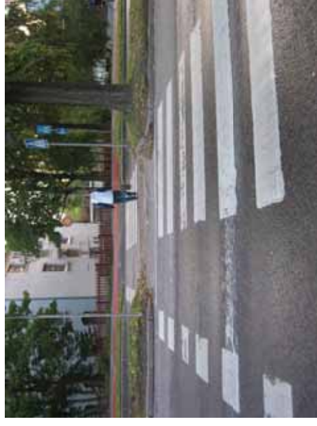
Kuva 42. Epätasainen keskikaista suojatiellä Kirkonkyläntielle.
