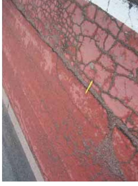
Kuva 32 b. Lähikuva halkeamista
