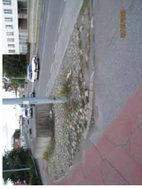
Kuva 28. Purkautumassa oleva kenttäkiveys Latokartanonttiellä Pekanraitin kohdalla
