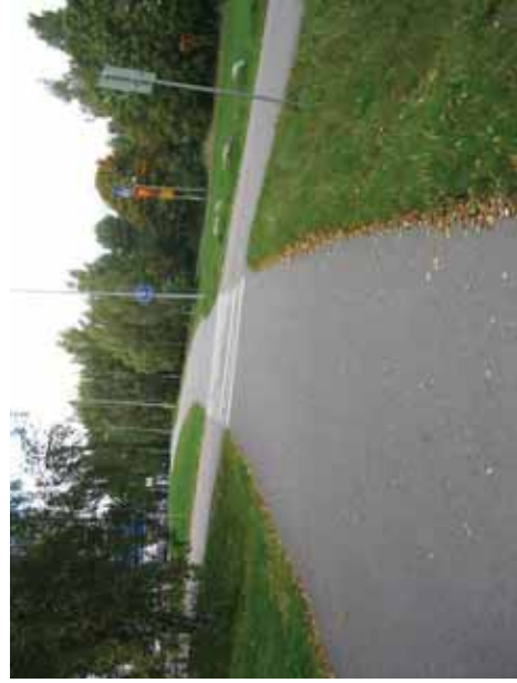
Kuva 83. Kevyen liikenteen väylä vaurioton ja tasainen, kuntoluokka 1.
