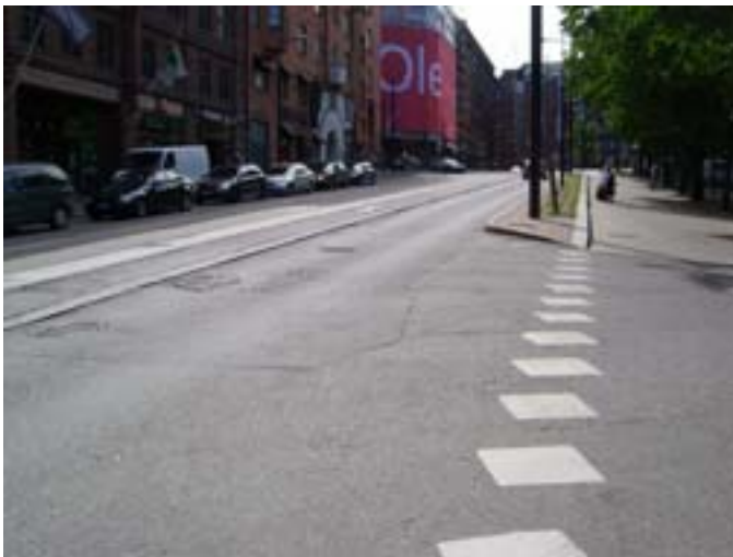
Keskusta: Simonkadun lämmitettyjen raitiovaunukiskojen sulamisvesi valuu talvisin autojen lämmittämättömälle ajoradalle ja tekee siitä vaarallisen liukkaan.
