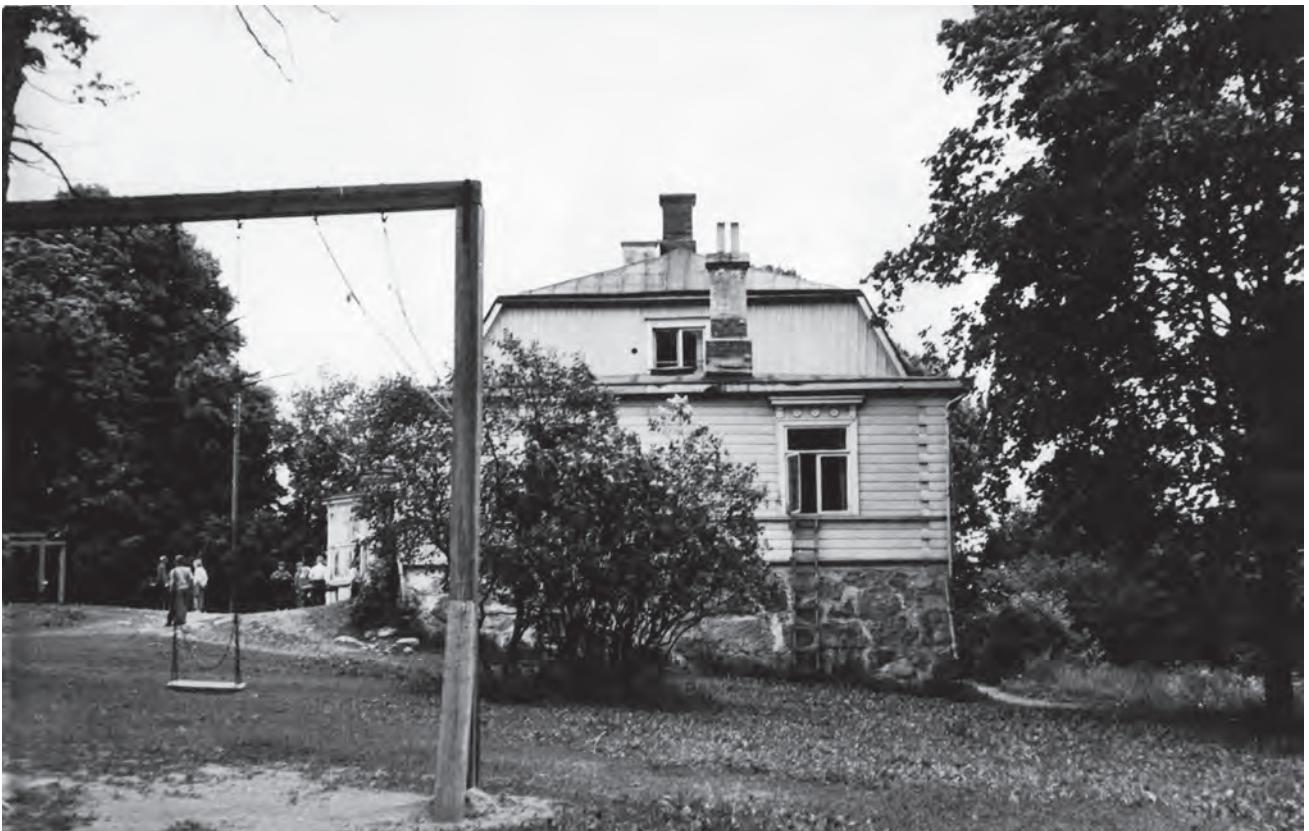
Päärakennuksen päädyssä sijaitsi 1950-luvun lopussa lasten keinu. Rakennuksessa asui tuolloin useita perheitä ja paljon lapsia. HKM.
