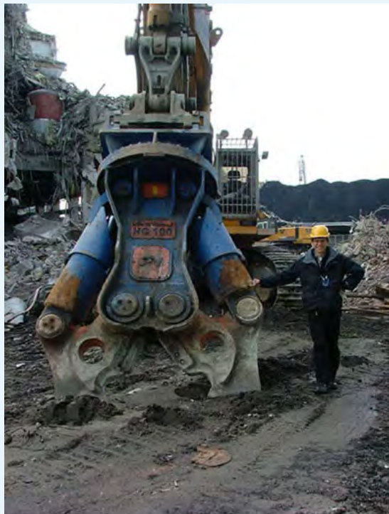
Rakennusten purkamisessa käytetään nykyisin yhä järeämpiä laitteita. Kuva: Matti Jokinen
