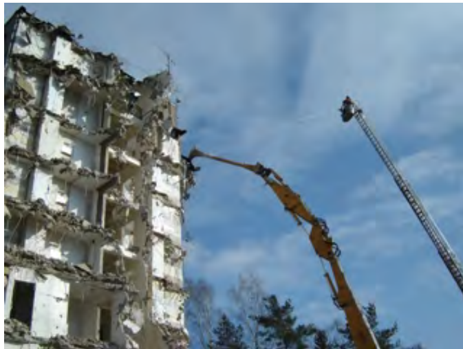
Purkutöissä on jätehuollon järjestämisen lisäksi huolehdittava pölyämisen estämisestä.
