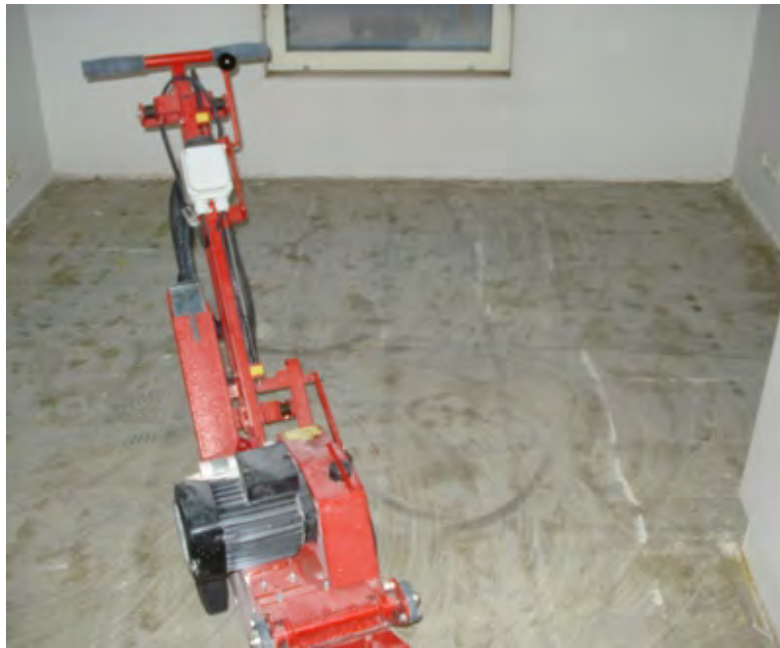
Muovimaton ja mattoliiman aiheuttaman terveyshaitan poistaminen vaatii mittavan korjauksen, jossa mm. lattialiima on hiottava huolellisesti pois. Kuva: Taija Poutiainen
