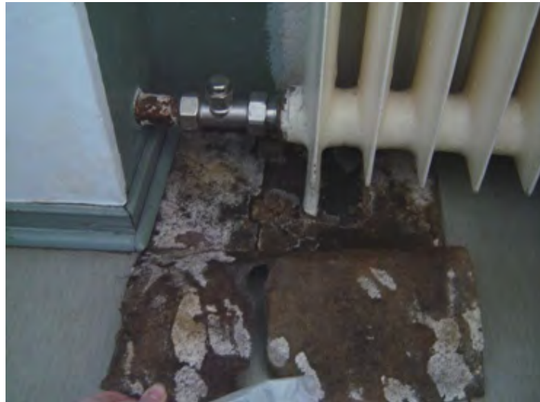
Kosteus- ja homevaurio on edelleen tavallinen syy terveyshaittoihin. Tässä patterivuoto on aiheuttanut homekasvuston lattiapinnoitteen alle. Kuva: Anne Hernesmaa
