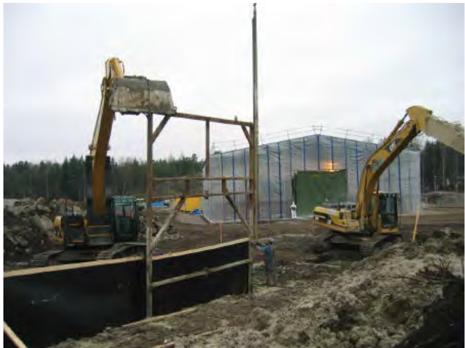
Myllypuron entiselle kaatopaikka-alueelle asennetaan pystyeristysseinää.
