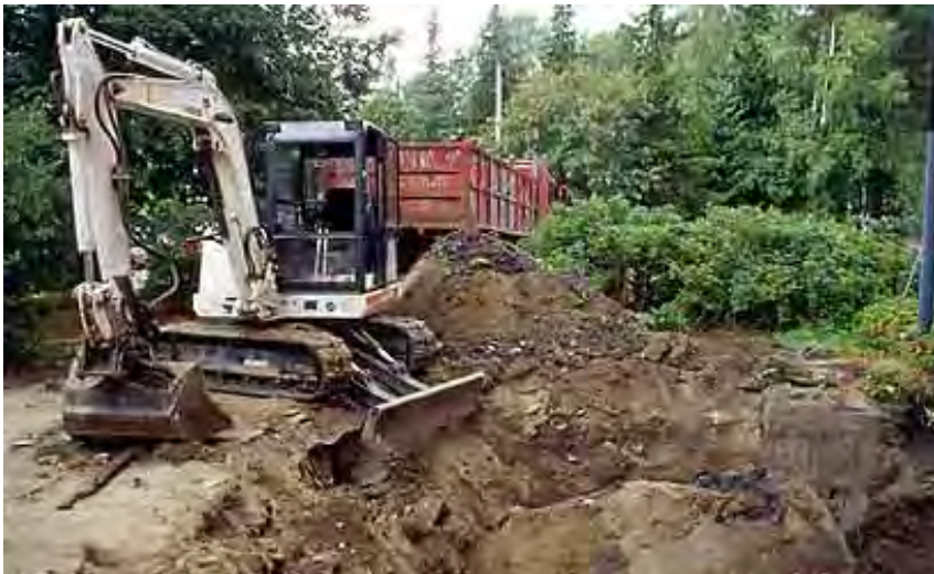
Kerrostalon käytöstä poistetun öljysäiliön nosto ja säiliöalueen maaperän kunnostus.
