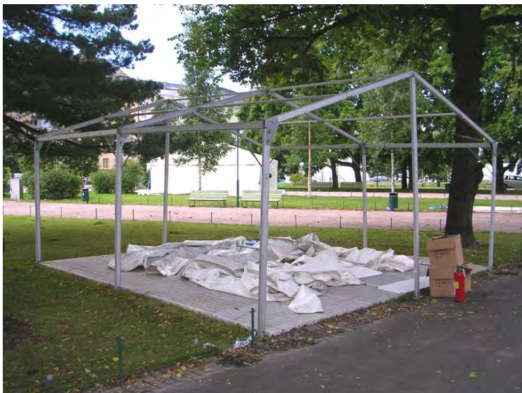
Kuva 7.1. Purkuvaiheessa oleva teltta, lattiana Terraplas-levyä.
