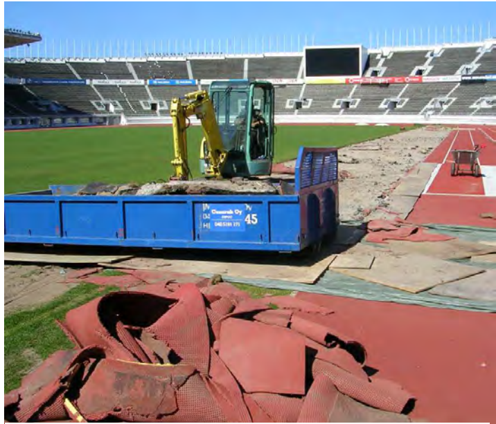
Kuva 8.1. Tilapäisen pituushyppypaikan purkua
