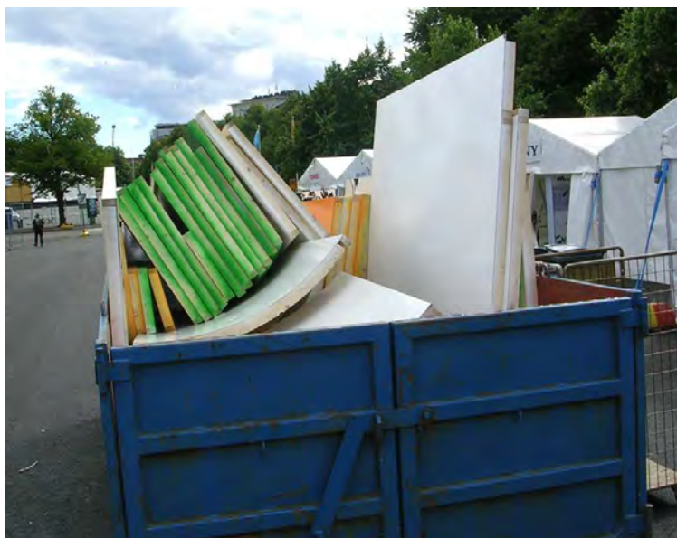
Kuva 4.3. MDF- ja lastulevyjä tukikehyksineen jätelavalla MM-kilpailujen purkuvaiheessa
