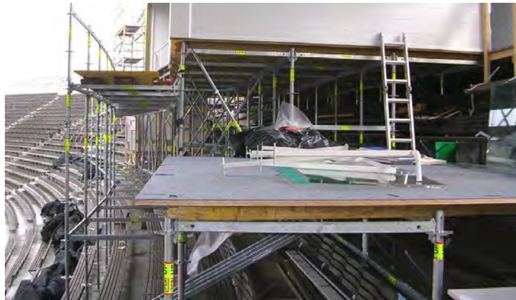
Kuva 7.10. Erään tv-studion vanerialusta, jonka päältä on purettu muu paitsi matto
