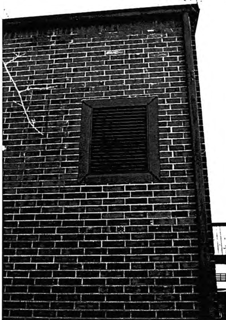
Kuva 5. Suojaamaton tuloilmanottoaukko
