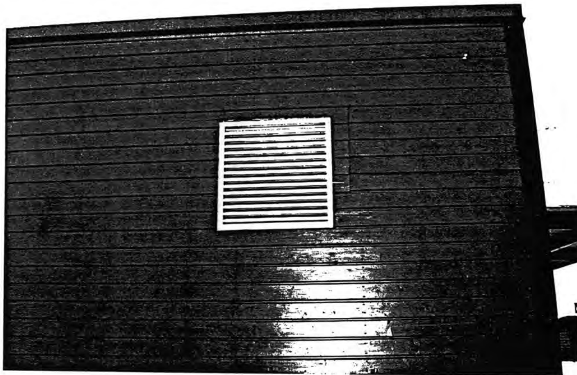
Kuva 2. Suojaamaton tuloilmanottoaukko
