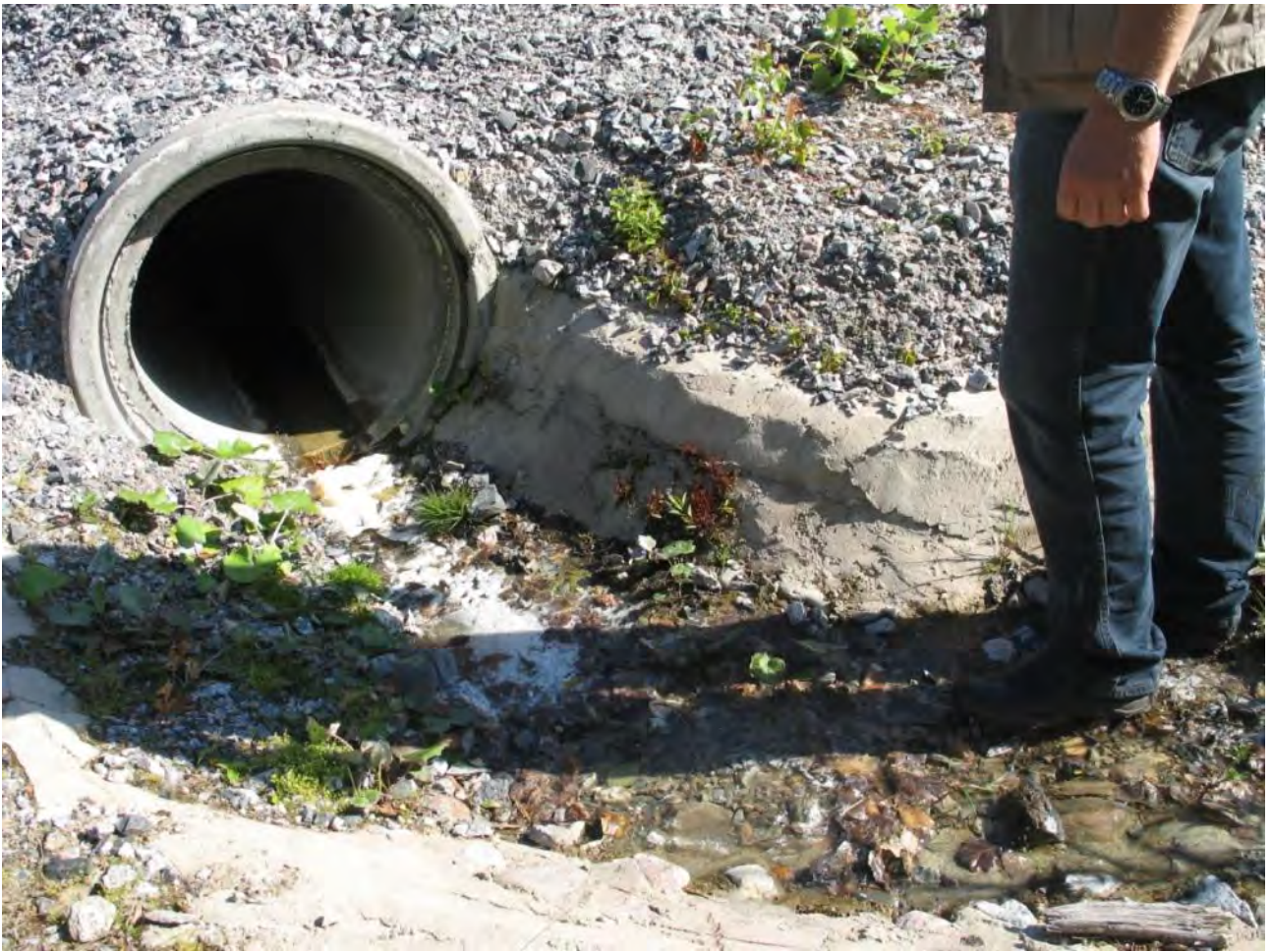
Peitetyn lähteen vesi tulee ojaan betoniputkessa.
