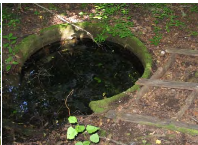
Kaivonrengas, joka olisi mahdollista poistaa.
