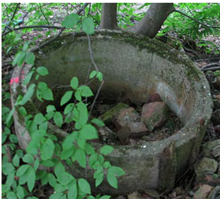
Kaivo oli kesällä 2011 kuiva.
