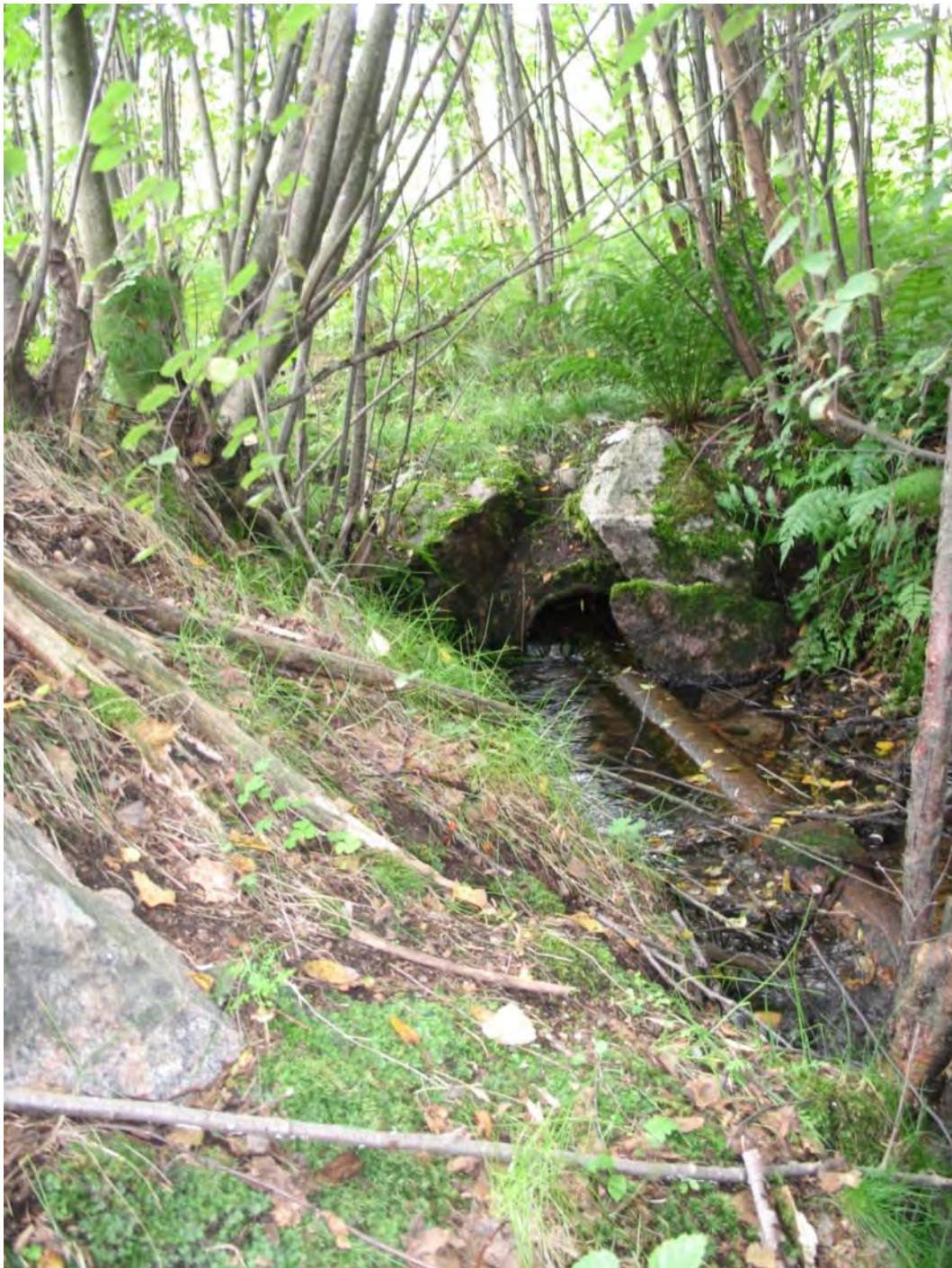
Pohjavesi virtaa Porvoonväylän liittymän alta betoniputkessa ojaan.
