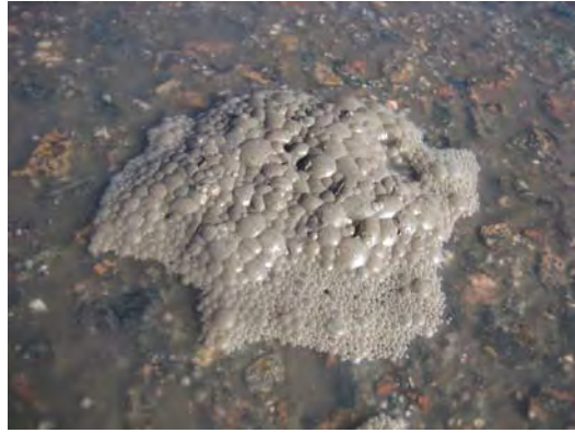
Kuva 58. MäntyEko-liuoksen aikaansaamia likakuplia kadun pinnalla Tuupakantiellä.
