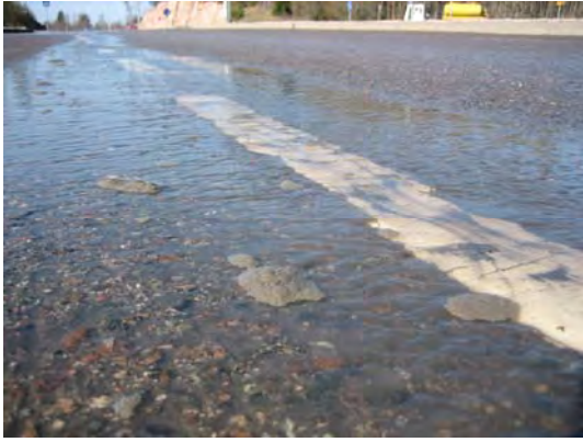
Kuva 58. MäntyEko-liuoksen aikaansaamia likakuplia kadun pinnalla Tuupakantiellä.
