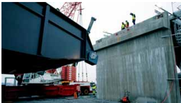
Teräsrampin asennusta satamatyömaalla 29. 10. 2007.
