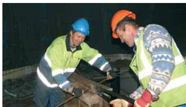
Rautatietunnelin raudoittajat töissä Saviolla 8/2007.
