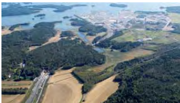
Satamatie ja tunnelien suuaukot maalta päin kuvattuna 11. 9. 2007.
