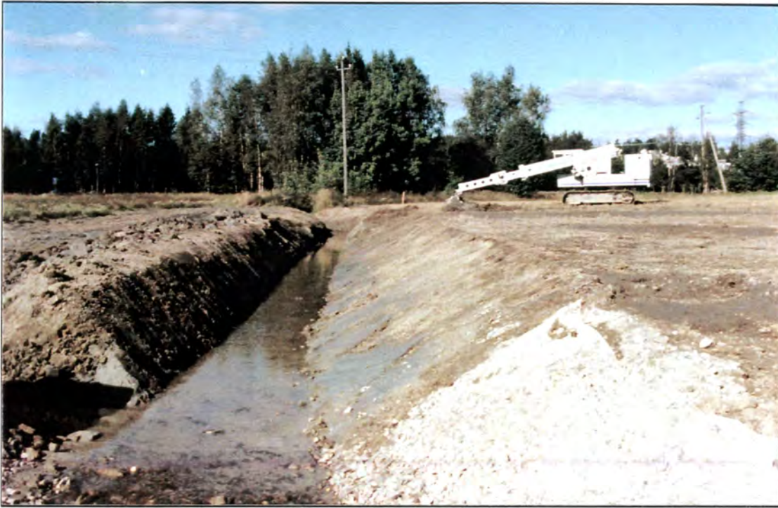
Kuva 13. Mellunkylänpuron pääuoman oikaisutyöt käynnissä Itäväylän eteläpuolella sijaitsevalla pellolla syyskuussa 1995.
