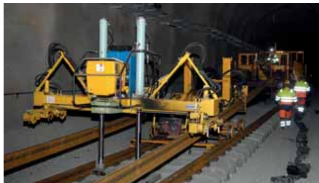
Viimeiset 150 metriä pitkät kiskot vedettiin paikoilleen 23.4.2008.
