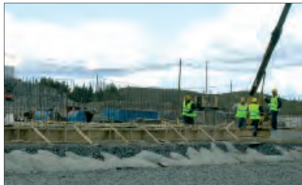
Kuva 10. Satamakentän rakennustyömaa kesällä 2004.
