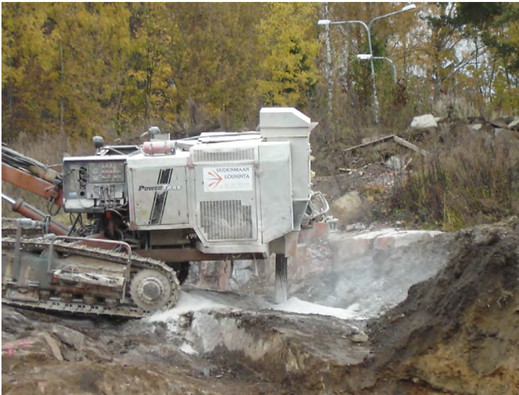
Kuva 5. Porauspölyn kerääminen on laiminlyöty. Kuva: Harri Pasanen.
