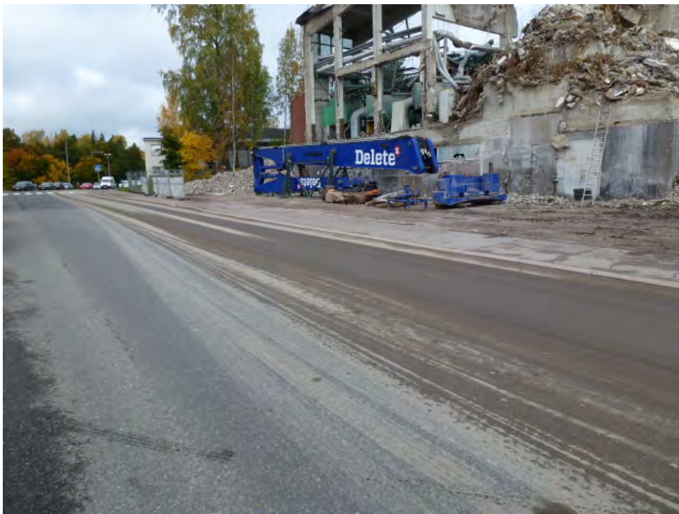
Kuvat 6 ja 7. Tällaiselta työmaalta lähdettäessä työmaaliikenne sotkee väistämättä läheiset kadut. Kuvat: Harri Pasanen.
