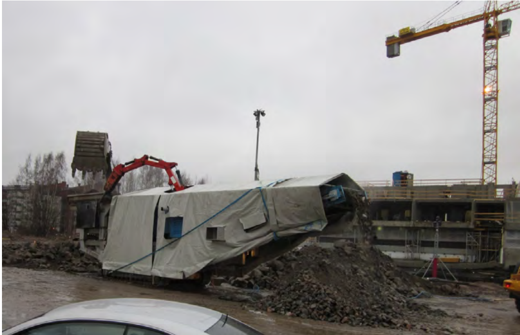
Kuva 1. Lähellä häiriintyviä kohteita murskaamo on sijoitettava tiiviin suojarakennelman sisään. Kuva: Harri Pasanen.
