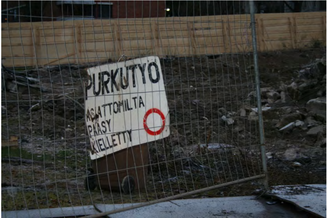
Kuva 3. Tiedottaminen kohteessa. Työmaataulu ei kerro mitään oleellista. Yhteystiedot löytyivät A4-paperilla kauempaa lauta-aidasta. Kuva: Eeva Summanen.
