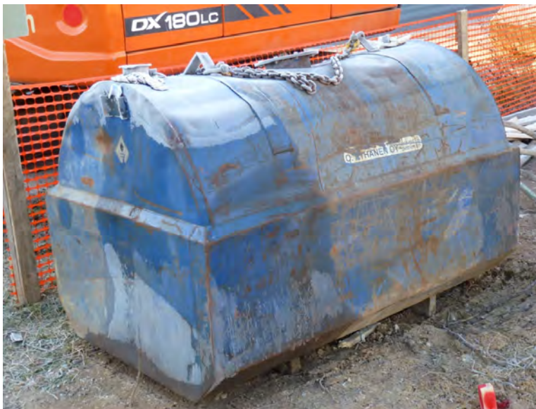
Kuva 9: Työmaalla ei useinkaan löydy tiivistä pinnoitettua alustaa varastosäiliölle, mutta säiliön pitäisi olla kunnossa ja imeytysainetta pitäisi olla aina saatavilla vahinkojen varalta. Kuva: Eeva Summanen.
