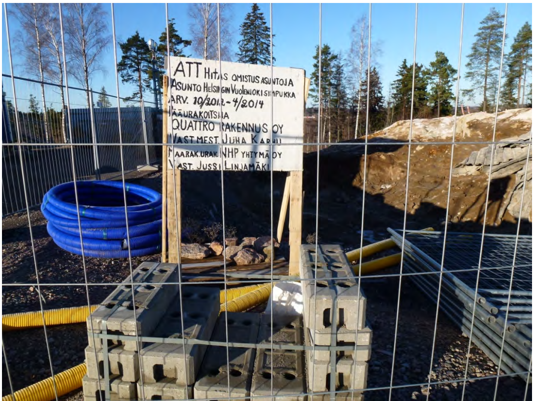
Kuva 4. Tiedottaminen kohteessa. Työmaataulusta puuttuvat mahdollista yhteydenottoa varten tarpeelliset puhelinnumerot. Kuva : Eeva Summanen.
