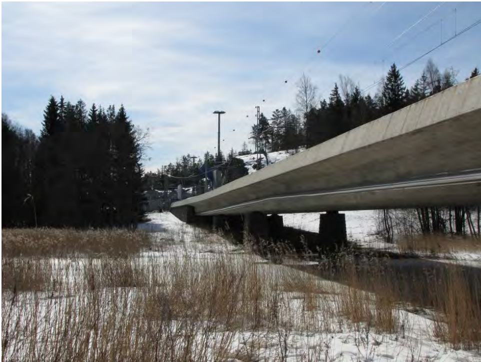
Kuva 16. Esimerkki eläinten liikkumisen kannalta hyvin suunnitellusta sillasta. Rannoilla olevaa maakaistaletta pitkin eläimet pääsevät alittamaan radan. Porvarinlahden ylittävä ratasilta.
