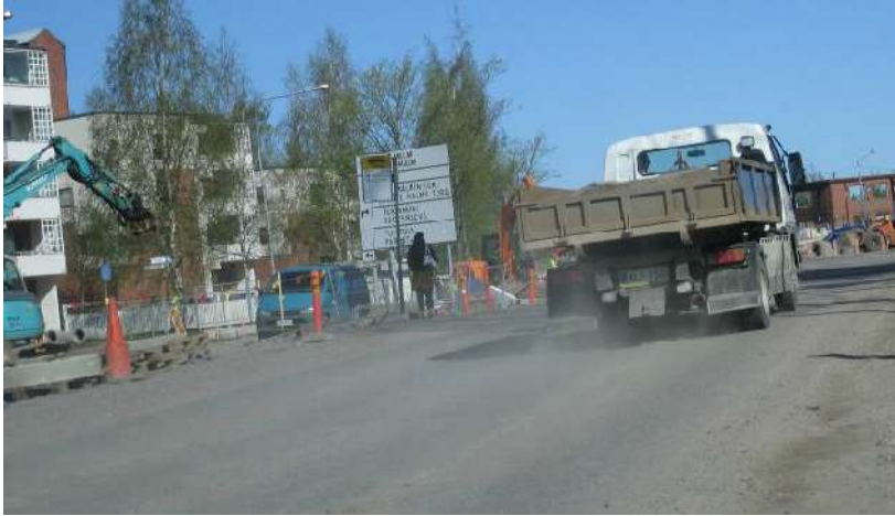
Kuva 61. Rakennustyömaa Helsingin Teerisuontiellä. Kohteessa oli katutyömaa ja suurrehko rakennustyömaa, joista aiheutui erityisesti lähistön asutukselle haittaa.
