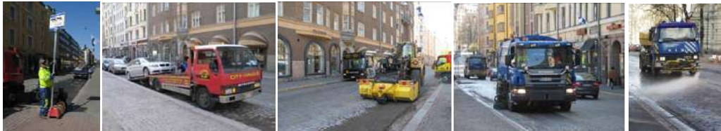
Kuva 60. Siirtokehotuskyltin asennus, ajoneuvon siirto, karkean hiekan poisto, imulakaisu ja pesu.
