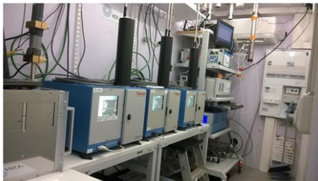
Mittausaseman sisällä on kymmeniä erilaisia ilmanlaadun mittalaitteita.
