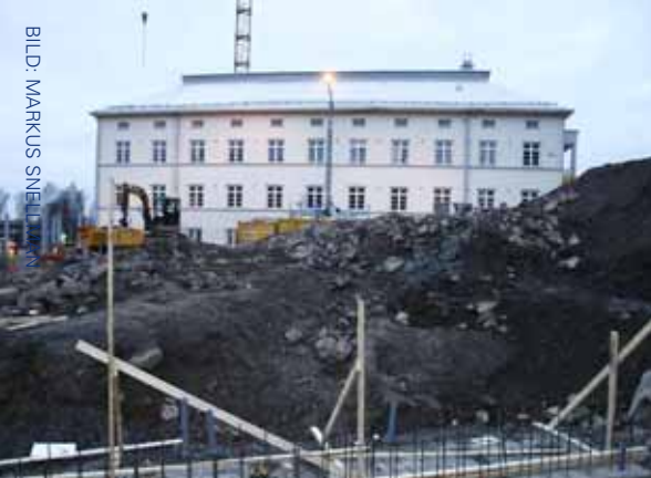
Ett nytt sjukhus med jourmottagning byggs i Malm
