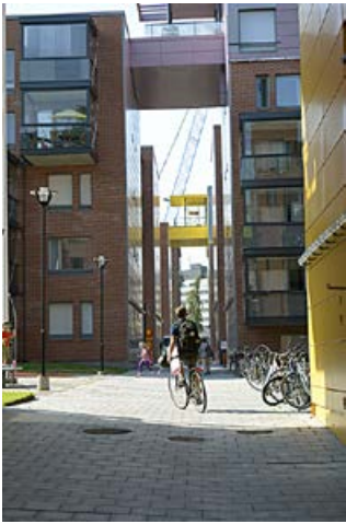
Fredriksbergs maskinverkstadsområde blir ett kvarter med kontor, affärslokaler och bostäder.
