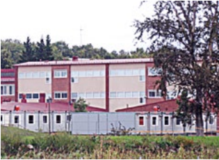
I Kasberget använder lågstadielklasserna vid Porolahden peruskoulu en paviljongbyggnad under ombyggnadsarbetena. Byggnadskostnaderna för skolans ombyggnad uppgår till ca 7 miljoner euro.
